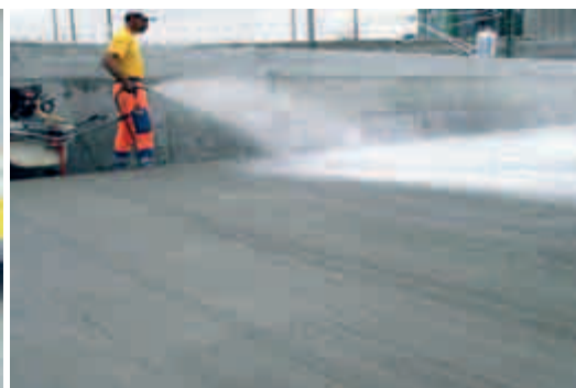
5 Wird der Nachbehandlung des Betons nicht genügend Aufmerksamkeit geschenkt, ist alle Mühe umsonst. Das Aufsprühen eines Curing Compounds schützt den Beton vor vorzeitiger Austrocknung.
