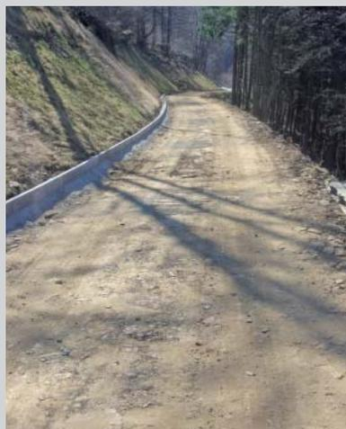
Fertige Rohplanie (bereit für den Betoneinbau)
