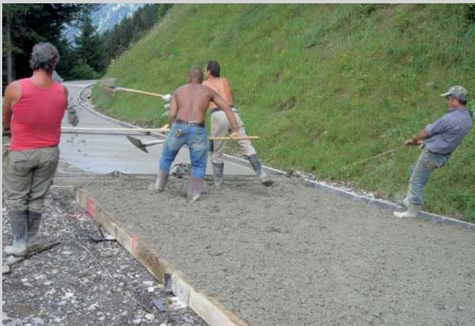
Betoneinbau: Abziehen mit Vibrobalken
