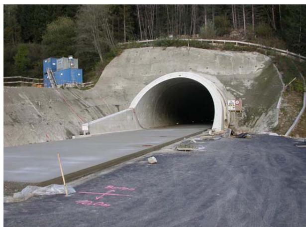
Abbildung 4: Betonfahrbahndecke im Herzogbergtunnel, Südatautobahn A2 Foto: VÖZ
