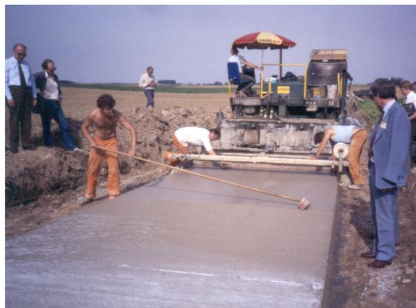
Abbildung 7: Einbau mit Fertiger Foto: Archiv ISTU
