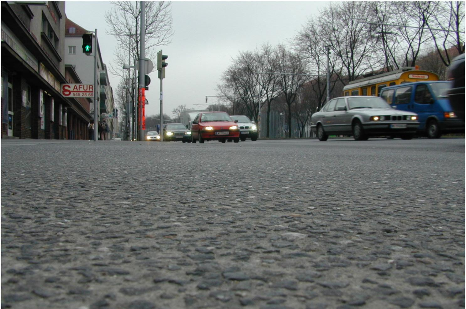
Abbildung 3: Waschbetonoberfläche – Margareten Gürtel Wien, 2007 Foto: VÖZ
