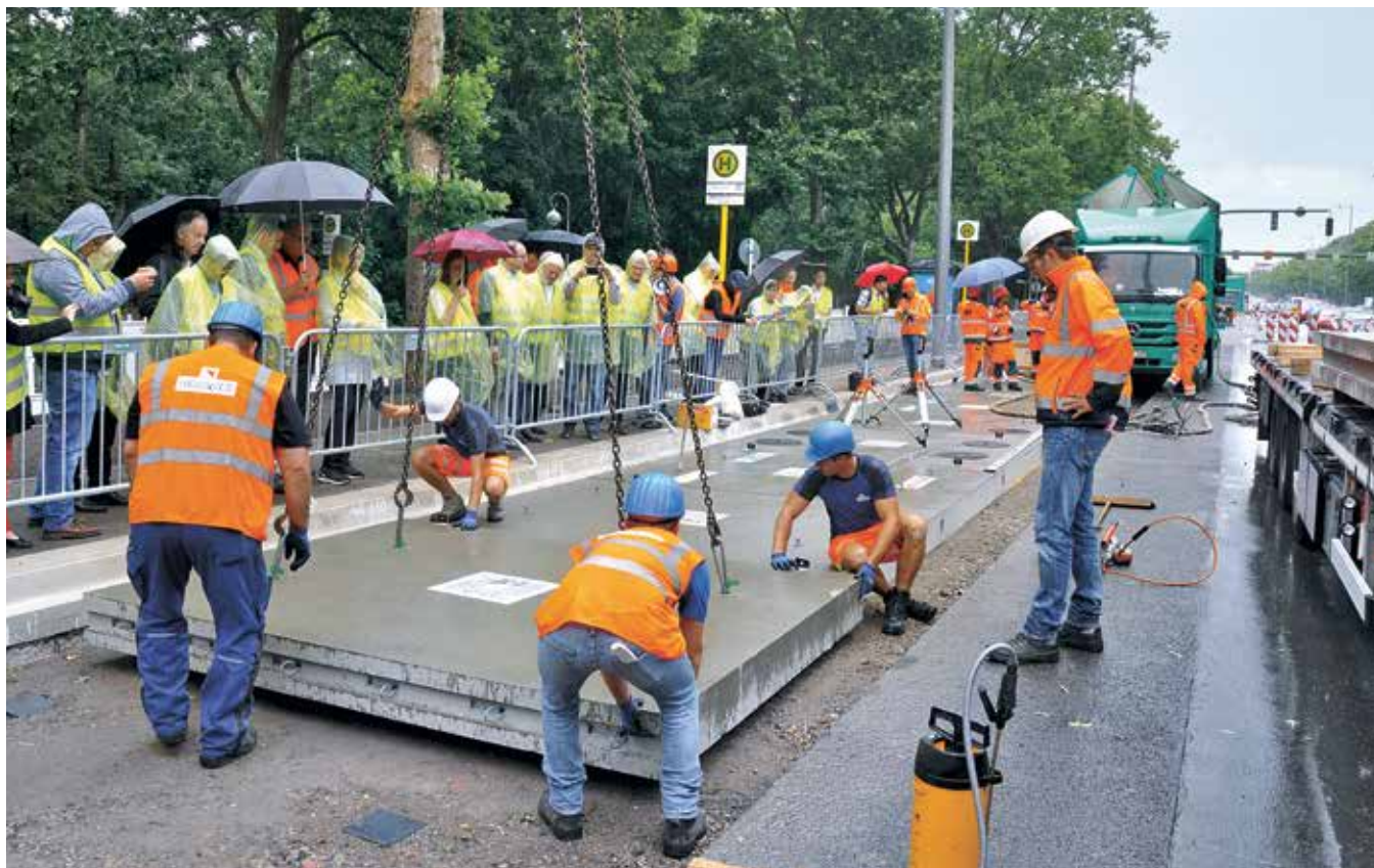
Besucher des Internationalen Betonstraßensymposiums beim Fertigteileinbau
