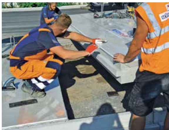
Verlegung eines Fertigteils mit Nut-Feder-System
