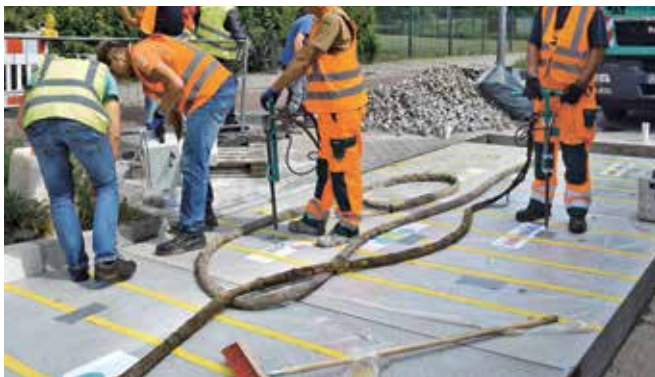
Unterfüllen der Fertigteile nach der Verlegung
