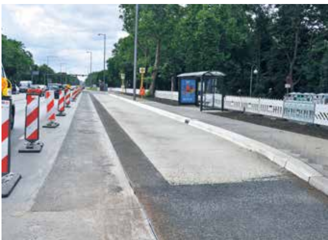
Fertiggestellte Bushaltestelle mit Fertigteilen
