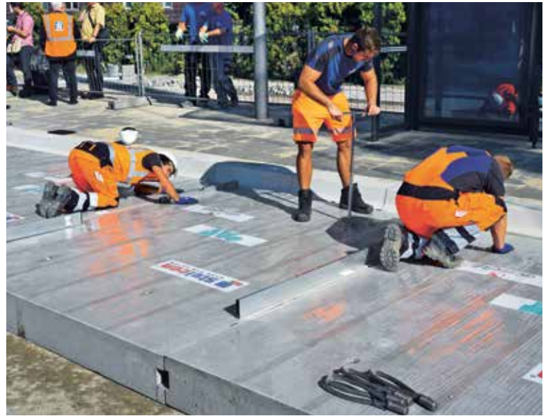
Ausrichtung und Höhenjustierung der Fertigteile
