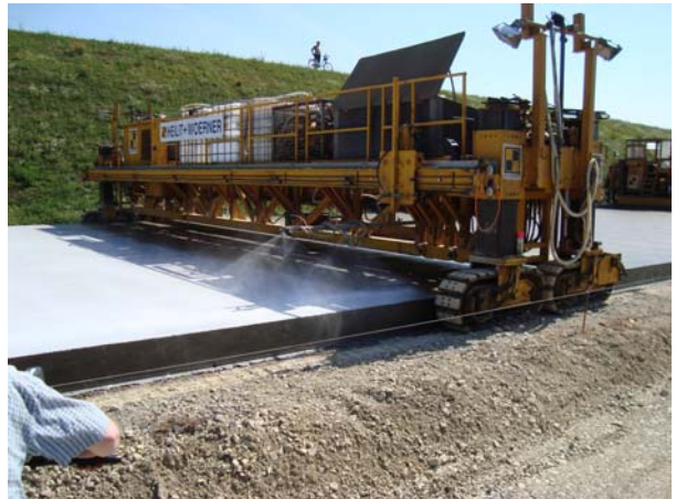
Fertige Waschbetonoberfläche (WB 0/8) mit Rautiefen von 0,78 bis 1,06 mm
