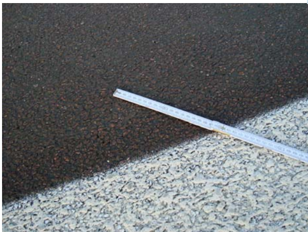
Fertige Waschbetonoberfläche (WB 0/8) mit Rautiefen von 0,78 bis 1,06 mm
