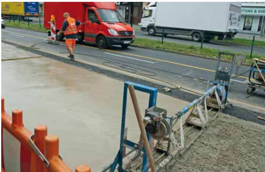
Bild 7: Betonage einer Bushaltestelle
