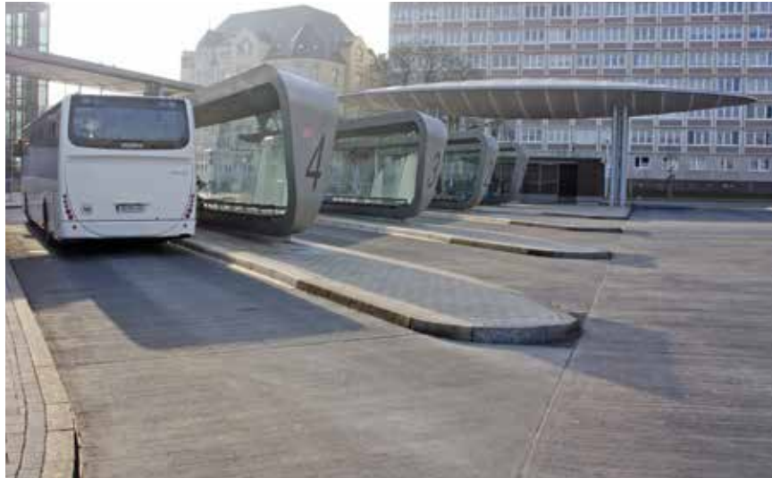
Bild 3: Busbahnhof in Betonbauweise
