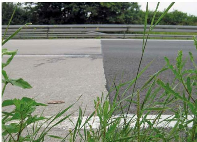
**Bild 4: Betondecke ohne Schäden am Übergang von Beton zu Asphalt (Baujahr Oktober 2004)**
