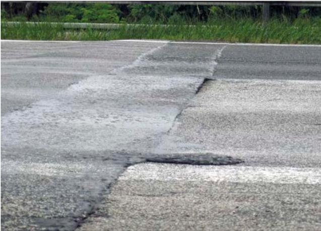
**Bild 6: Aufwölbung und zerstörter Fahrbahnübergang nach großer Hitze**
