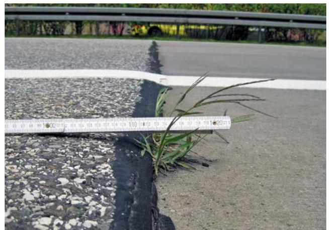
**Bild 5: Aufwölbung am Übergang Beton/Asphalt**
