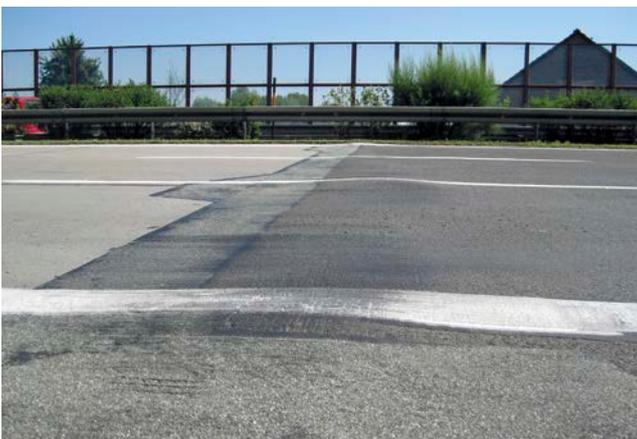
**Bild 8: Extreme Aufwölbungen durch falsche Raumfugeneinlagen**
