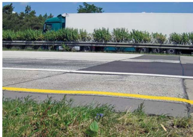
Bild 2: Aufwölbung in Asphaltkonstruktion
