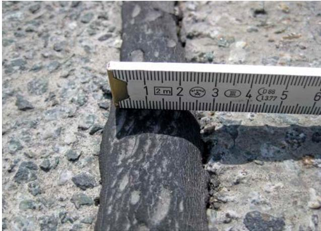
**Bild 10: Funktionierende Raumfuge**
