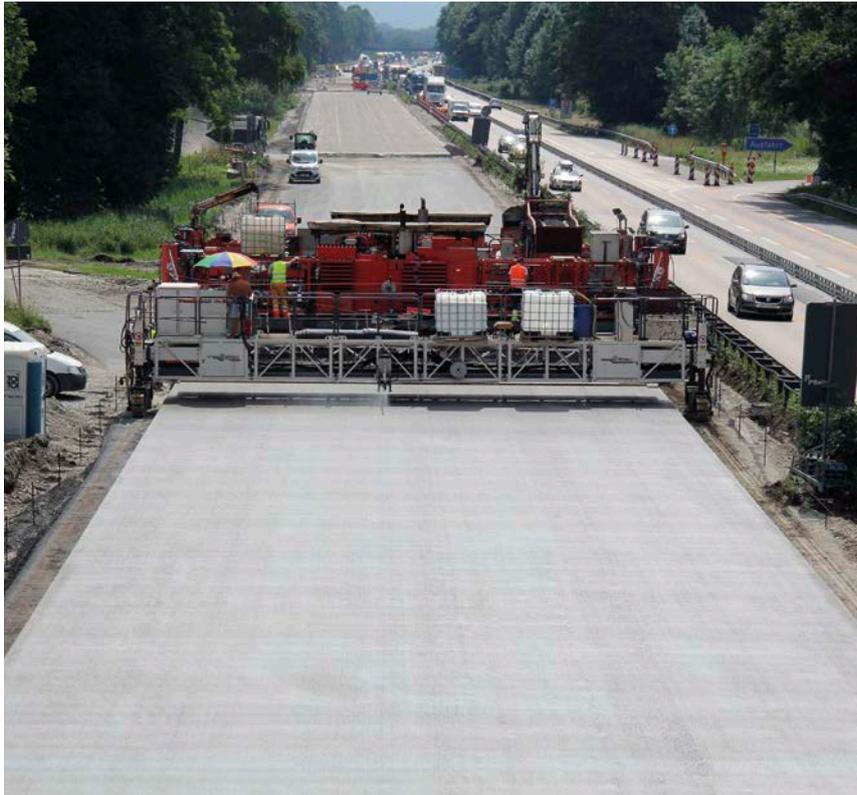
**Bild 7: Deckeneinbau auf der A 93 Süd**
