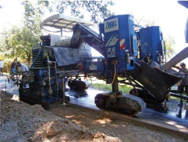
Bild 16: Betoneinbau mit Offset-Gleitschalungsfertiger
