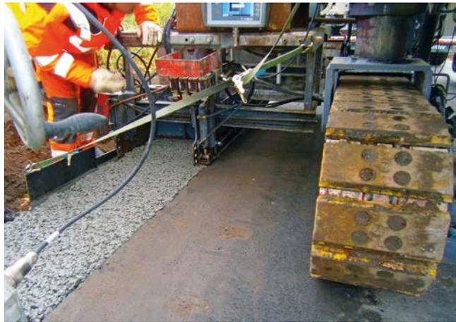
**Bild 4: Fertiger Bankettstreifen hinter dem Offset-Gleitschalungsfertiger**
