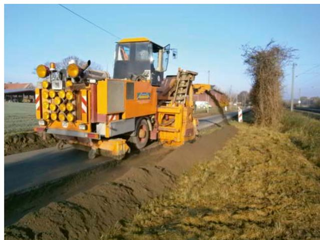
**Bild 2: Ausbau des vorhandenen Banketts mit der Bankettfräse**
