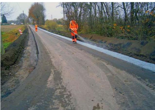
**Bild 7: Nachbehandlung des eingebauten Bankettbetons**
