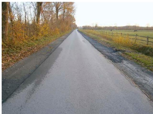
**Bild 1: Zustand der Bankette „Im Aatal“ vor der Instandsetzung**
