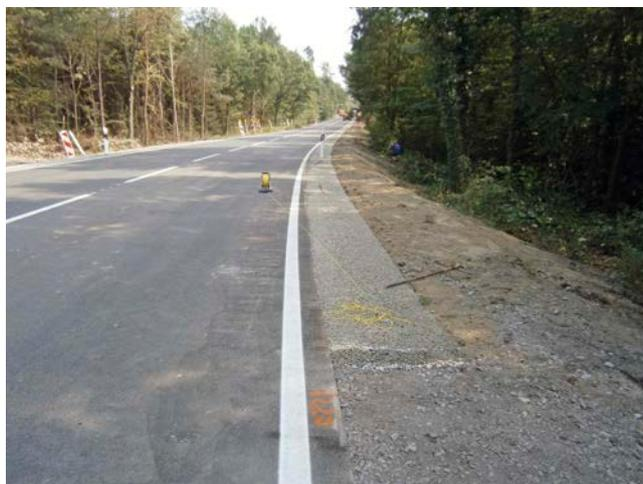
**Bild 28: Fertiges Bankett mit Hinterfüllung**
