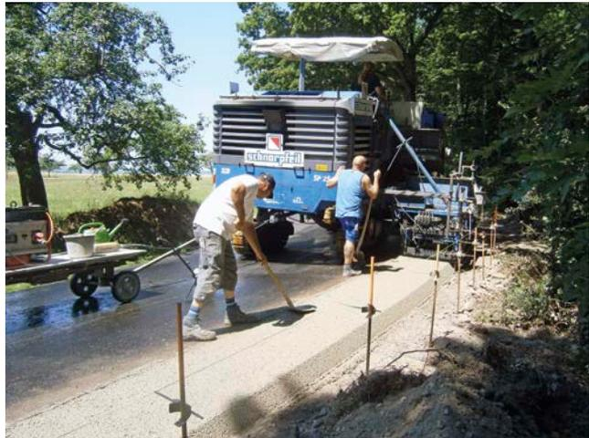
Bild 17: Bankettbeton hinter Einbaumulde
