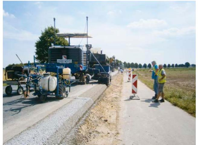
**Bild 21: Betoneinbau und Nachbehandlung des Bankettbetons**
