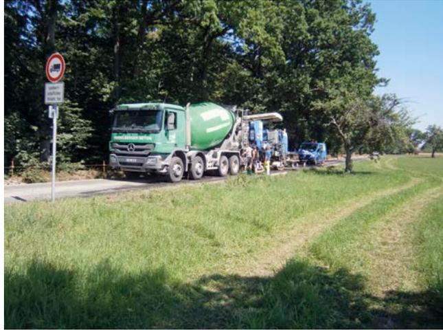
Bild 15: Equipment für Bankettbetoneinbau
