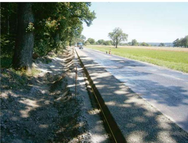
Bild 18: Fertiger Bankettbetonstreifen
