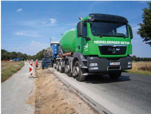
**Bild 20: Bankettbetoneinbau mit Offset-Gleitschalungsfertiger**
