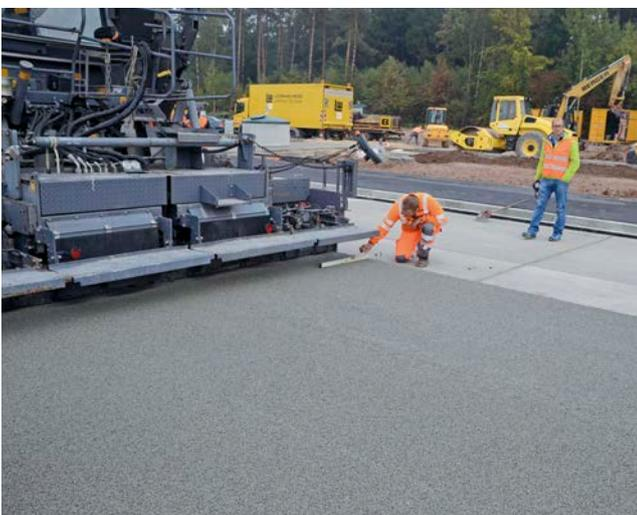
Bild 2: Einbau des OPB mit spezieller Hochverdichtungsbohle
