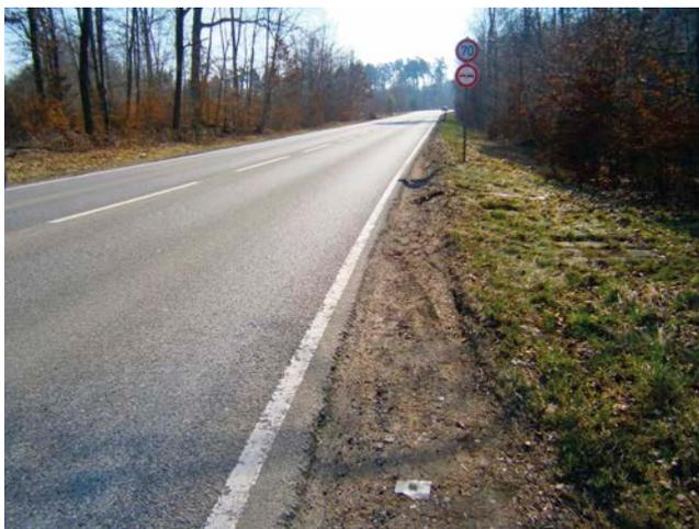
**Bild 23: Bankettzustand vor der Sanierung**
