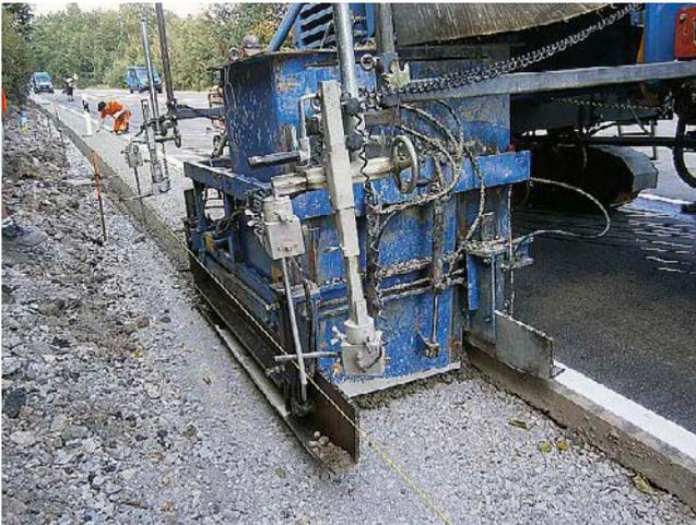
**Bild 25: Bankettbeton-Einbaumulde**
