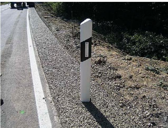
**Bild 27: Eingebauter Leitpfosten**
