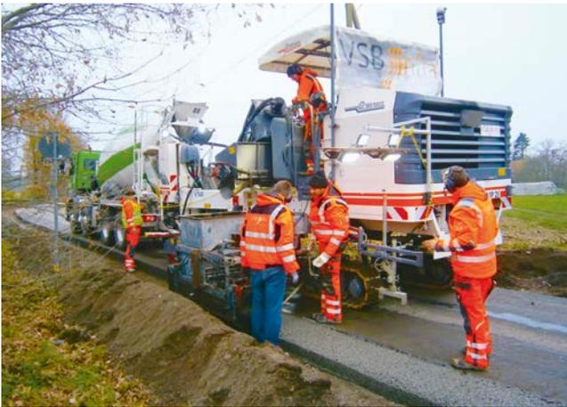
**Bild 3: Bankettbetoneinbau mit dem Offset-Gleitschalungsfertiger**
