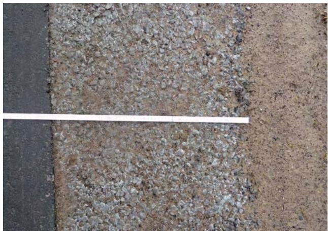
**Bild 6: Hinterfüllter und mit Erdreich angedeckter Bankettbeton**
