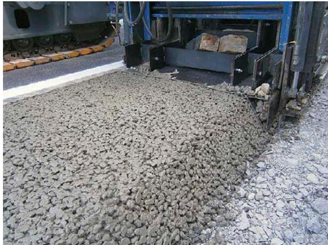
**Bild 26: Bankettbeton hinter der Einbaumulde**
