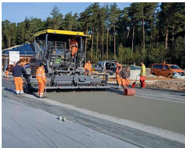
Bild 3: Einbau des OPB auf dem PWC Silberbach an der BAB A6
