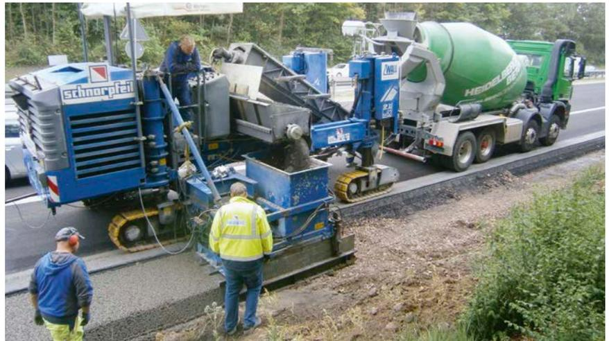
**Bild 9: Bankettbetoneinbau mit Offset-Gleitschalungsfertiger**
