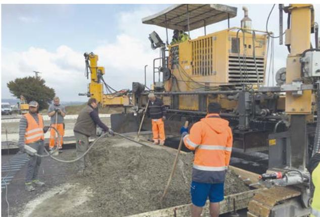
**Bild 5: Glasfaserbeton, Einbau mit Fertiger**
