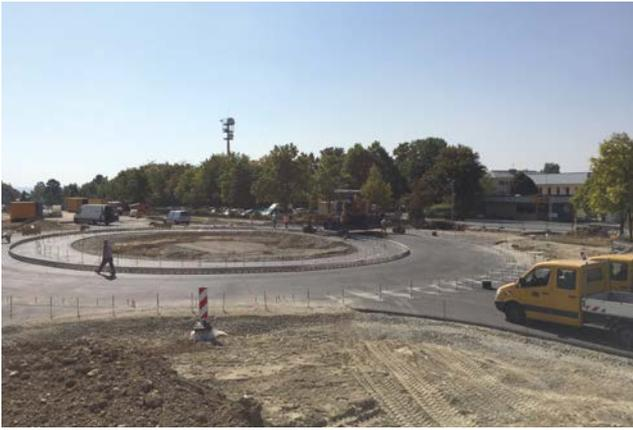
**Bild 3: Vorbereitete Asphalttragschicht**
