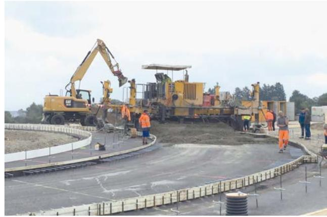
**Bild 4: Glasfaserbeton, Einbau mit Fertiger**
