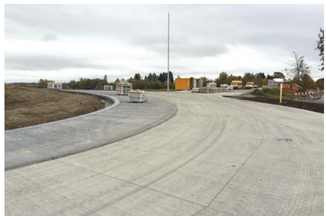
**Bild 6: Kreisverkehr aus Glasfaserbeton, fertige Betondecke**
