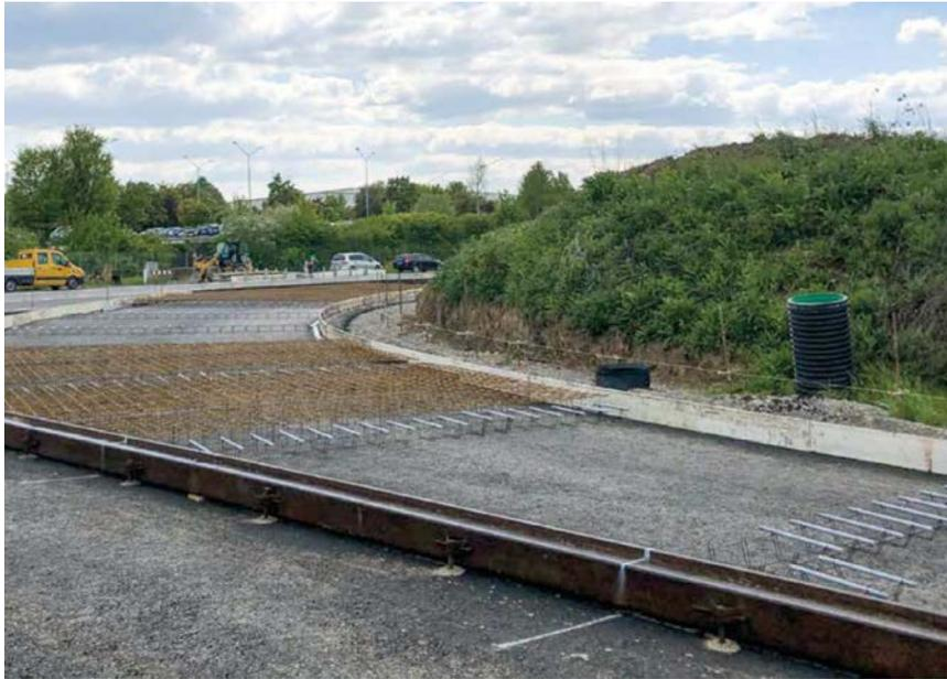
**Bild 5: Asphalttragschicht mit Randschalung, Dübelkörben und partieller Bewehrung**
