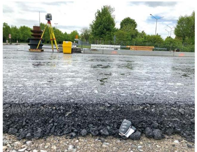
**Bild 11: Die acht Zentimeter dicke Asphalttragschicht**
