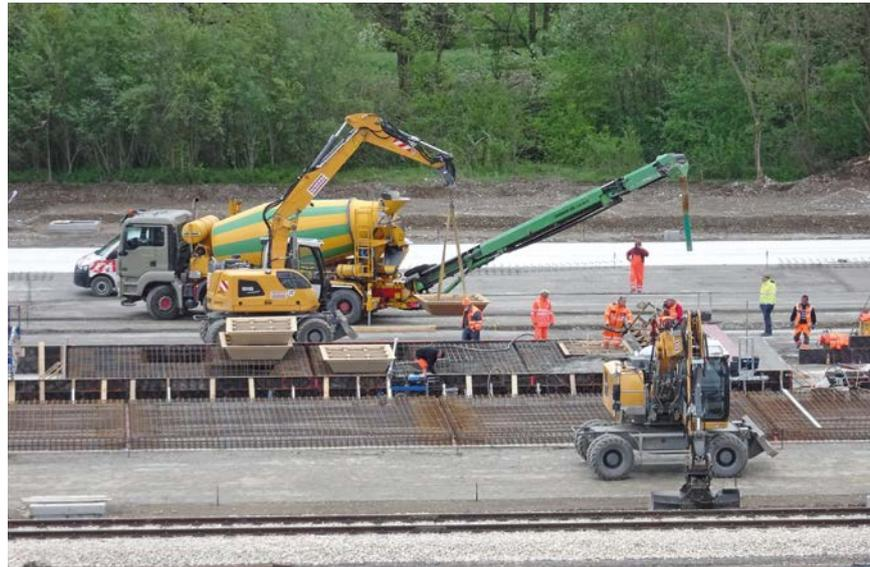
**Bild 5: Einbau einer Bahn mit Vertiefungen**
