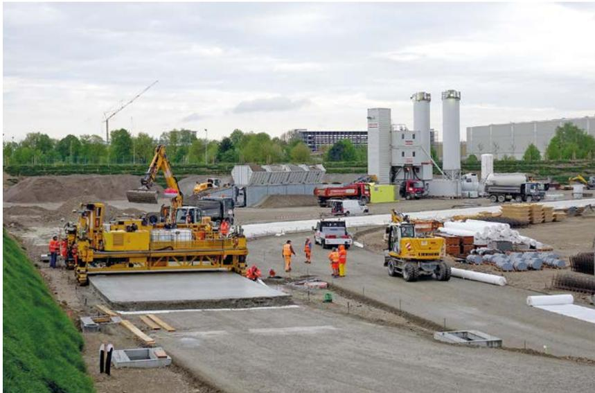
**Bild 2: Gleitschalungsfertiger und Betonmischanlage**
