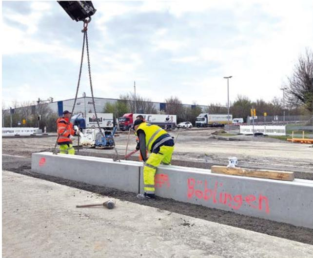
**Bild 8: Erneuerung und Ertüchtigung der Entwässerung mit Hilfe von Betonfertigteilen**
