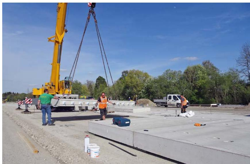
**Bild 7: Verlegen der Fertigteile**
