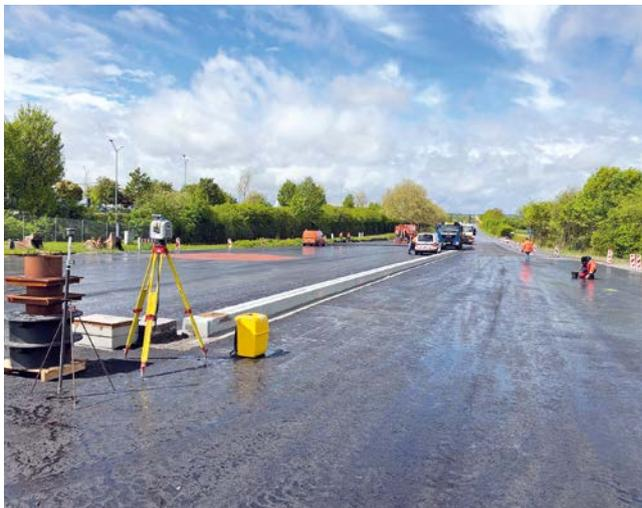
**Bild 10: Die Asphalttragschicht nach dem Einbau**
