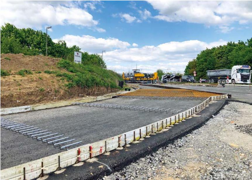
**Bild 12: Befestigung von Randschalung und Dübelkörben auf der Asphalttragschicht**
