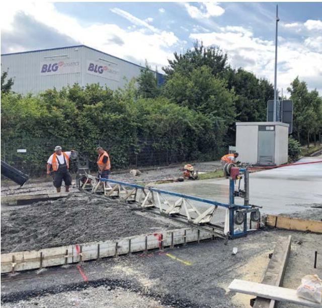
**Bild 13: Deckenherstellung im Handeinbau**
