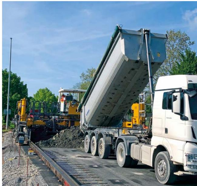
**Bild 14: Betonlieferung per Sattelzug**
