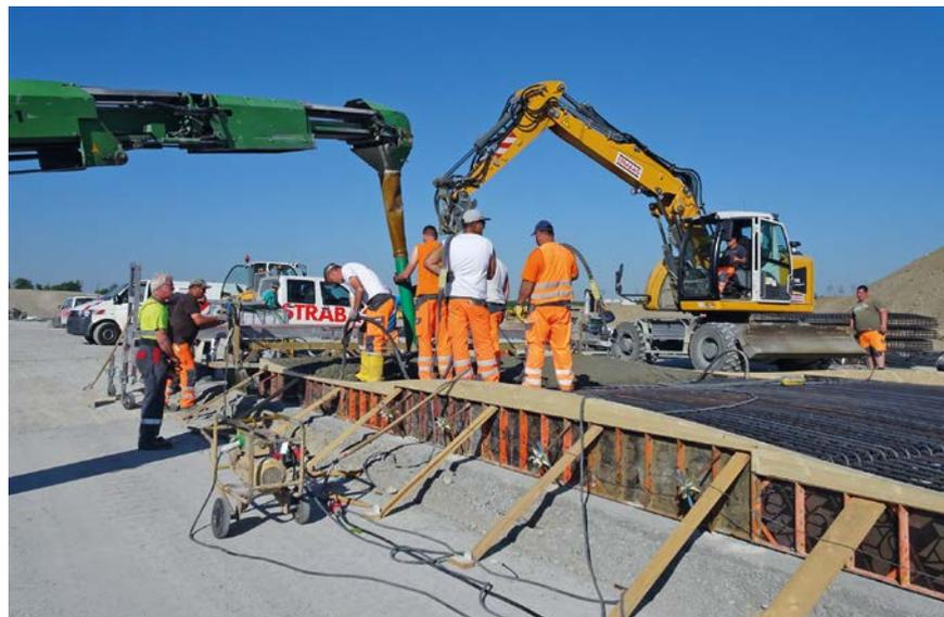
**Bild 6: Einbau einer Bahn mit Wellen**
