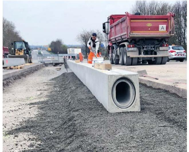
**Bild 9: Schlitzrinnen aus Betonfertigteilen**
