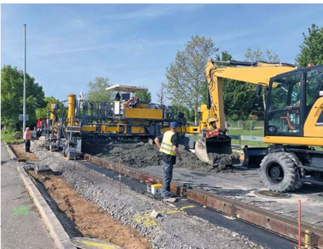
**Bild 15: Anfahren des Gleitschalungsfertigers**
