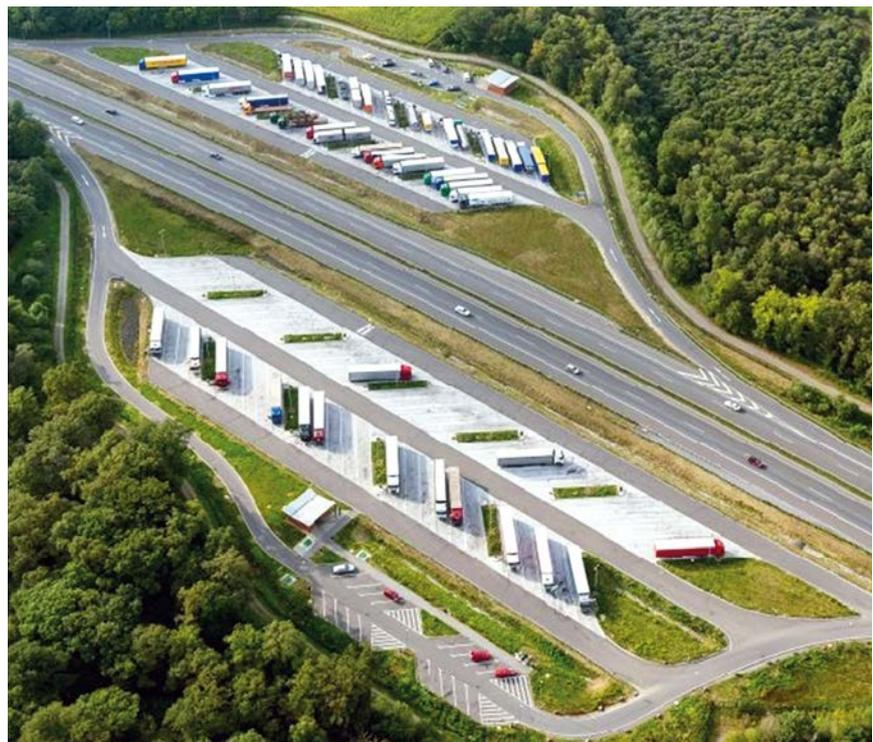
**Bild 2: Lkw-Parkplatz mit Stellplätzen in Beton und Fahrgassen in Asphaltbauweise**
