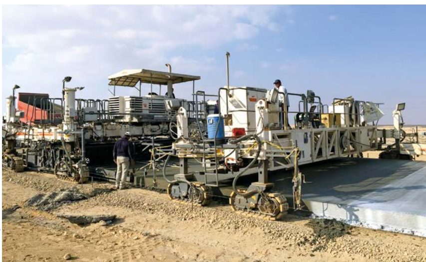
Bild 6: Fertigungseinheit und Nachbehandlungsbühne in kurzer Prozessfolge
