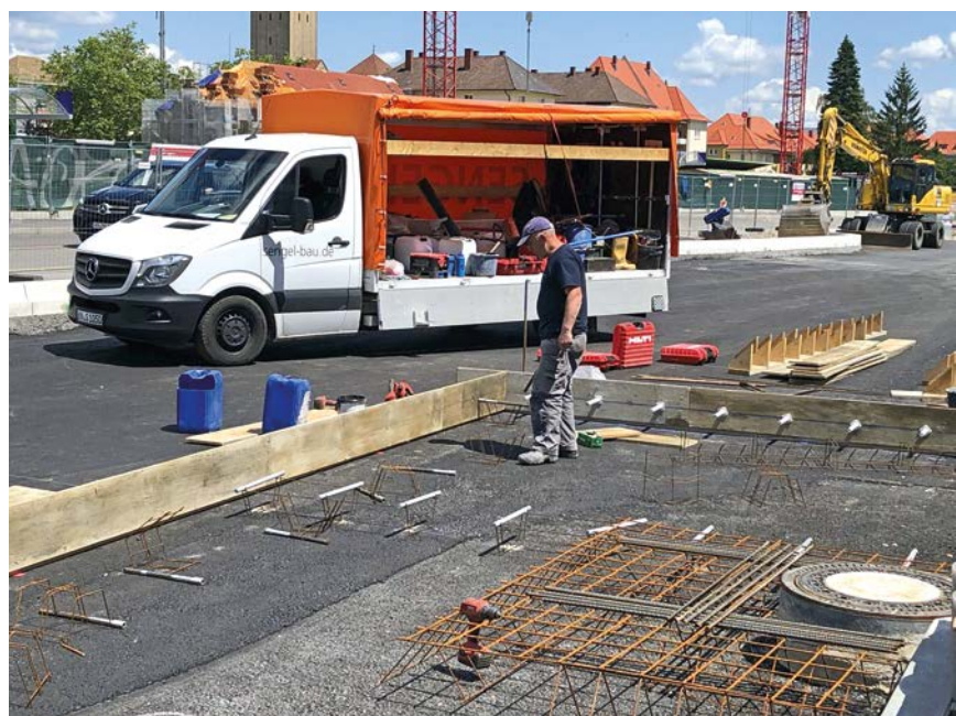
Bild 4: Seitenschalung, Asphalttragschicht und vorbereitete Dübelkörbe
