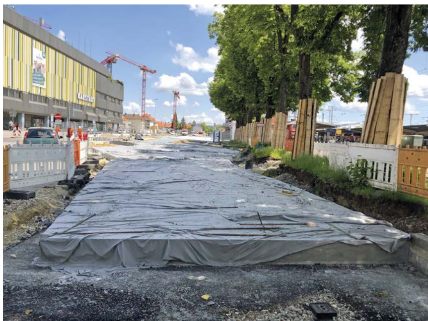
Bild 5: Nachbehandlung der Betonplatten; sie wurden mit wasserhaltenden Vlieslagen oder strapazierfähiger Folie bedeckt, eingepackt und gewässert.
