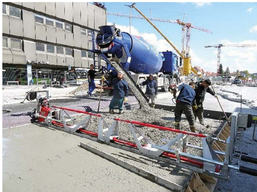
Bild 3: Betoneinbau mit manueller Vorverdichtung und Rüttelbohle
