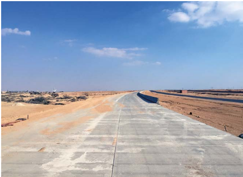
Bild 1: Betondecke nach Fugenschnitt im Wüstenklima
