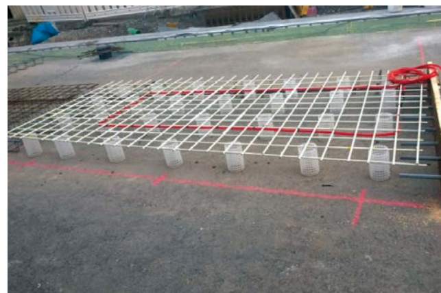
Bild 17: Verwendung von Bewehrung aus Glasfasern für den Bereich der Induktionsschleifen
