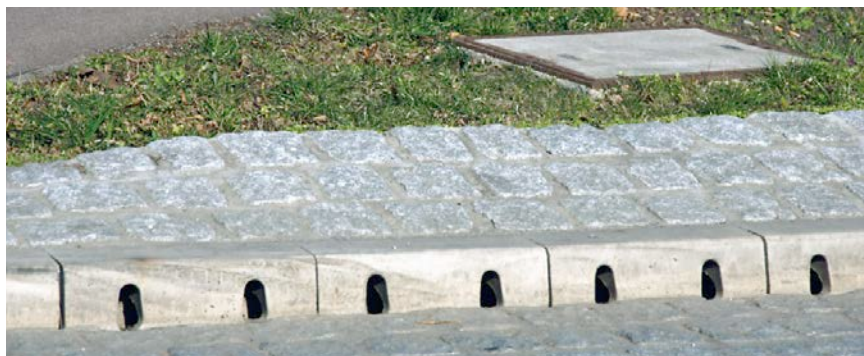
Bild 1: Beispiel einer Linienentwässerung
