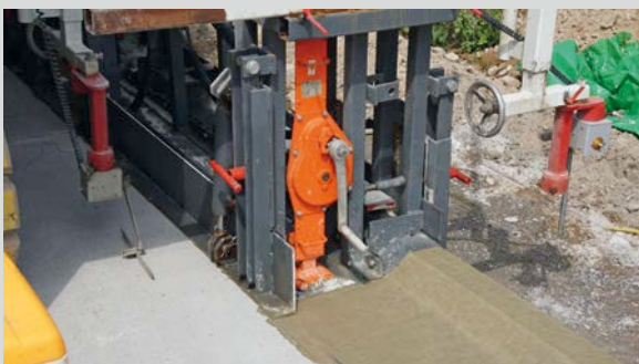
Bild 2: Bordrinne in Ortbetonbauweise
