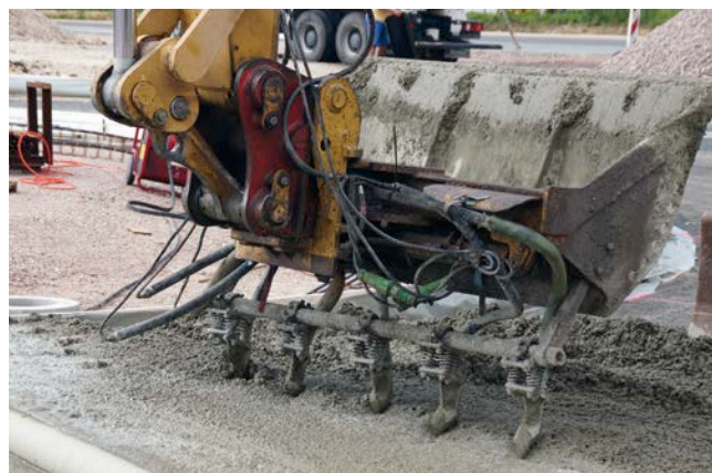
Bild 9: Einbringen und Verdichten
