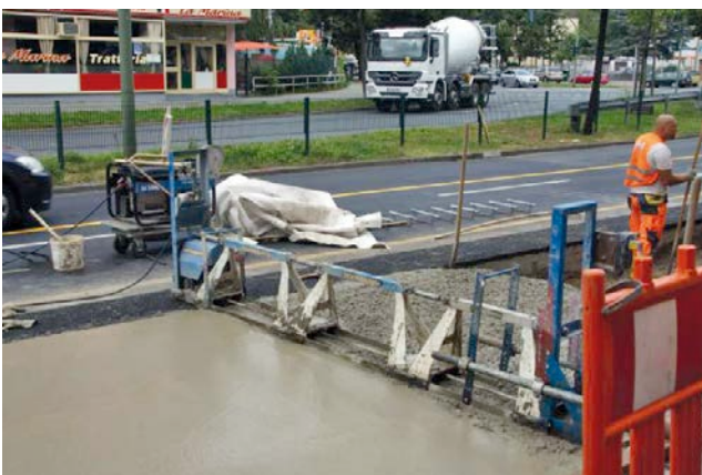
Bild 8: Einbau mit Rüttelbohle
