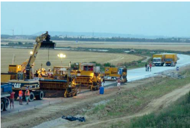
Bild 6: Einbau mit Gleitschalungsfertiger
