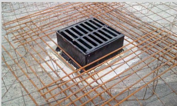
Bild 4: Beispiel einer rissbreitenbeschränkenden Bewehrung an einem Straßenablauf in künftiger Betonfläche
