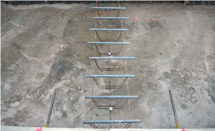
Bild 5: Einbau der Dübel auf Stützkörben
