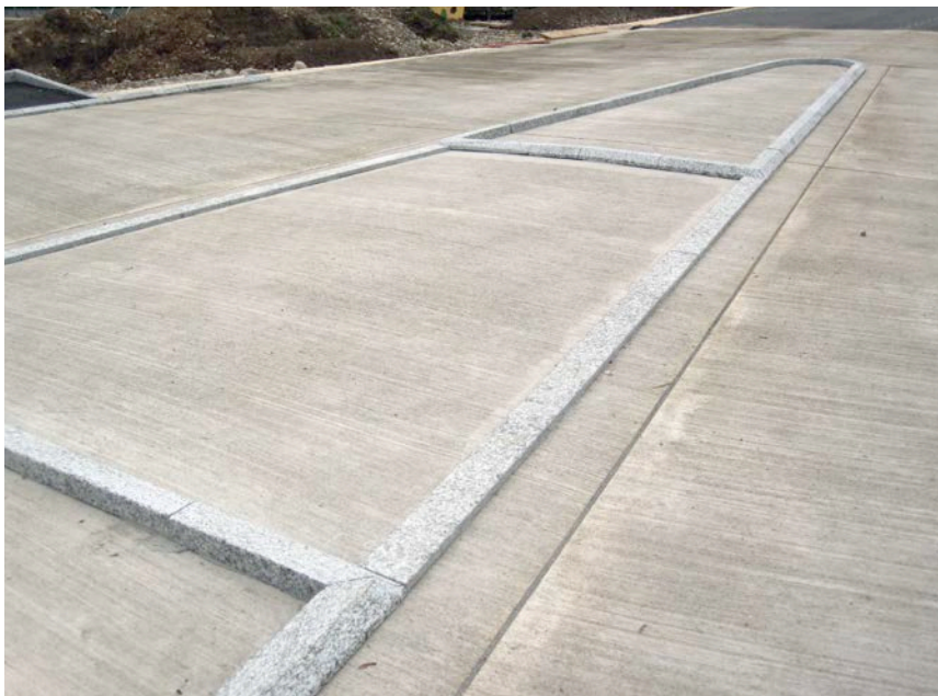
Bild 3: Aufgeklebte Granitborde
