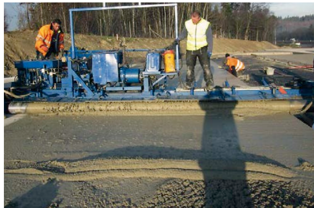
Bild 7: Einbau mit Walzenfertiger
