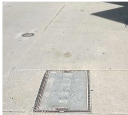
Bild 15: Beispiel Fugenbild am Fernmeldeschacht
