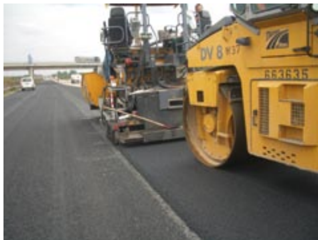
Bild 7: Einbau von 3 cm SMA auf SAMI- Schicht
