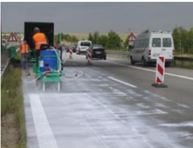
Bild 4: Applikation Hydrophobierung
