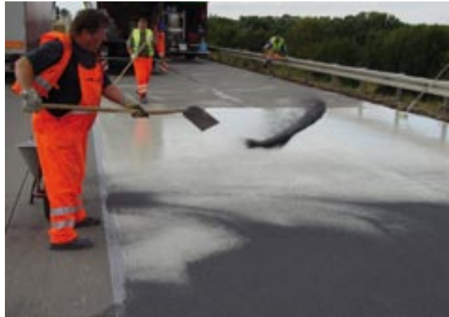
Bild 3: Applikation Epoxidharzbeschichtung
