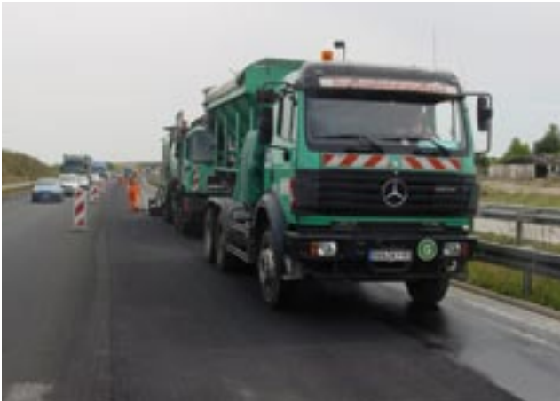
Bild 2: Einbau DSK 0/5
