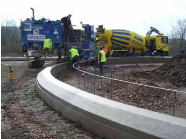
Bild 1: Bord in Ortbetonbauweise
