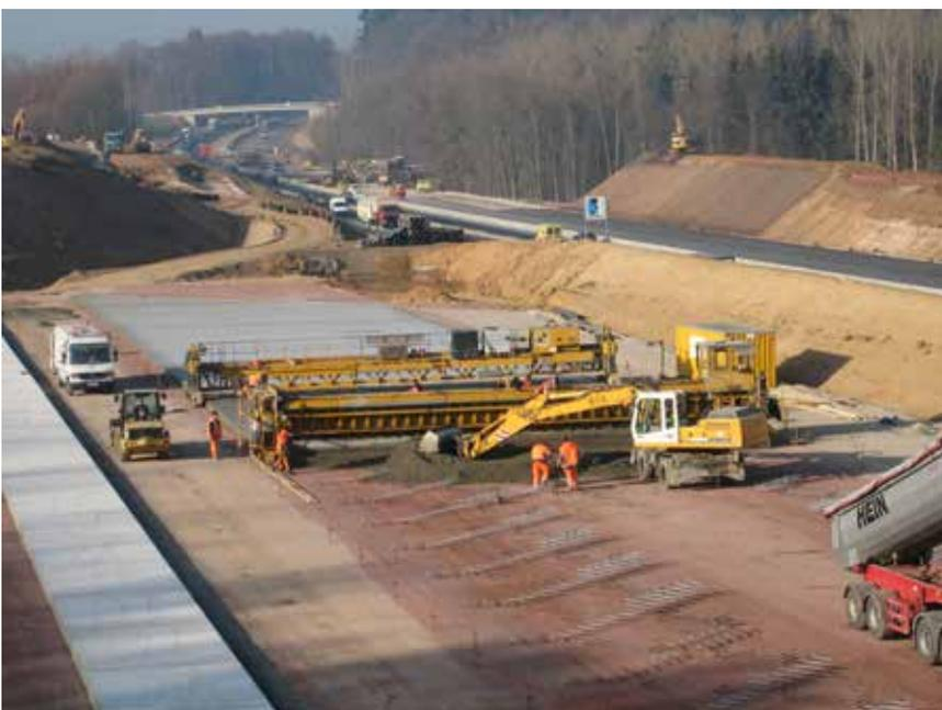
**Bild 5: Einbau mit Gleitschalungsfertiger**
