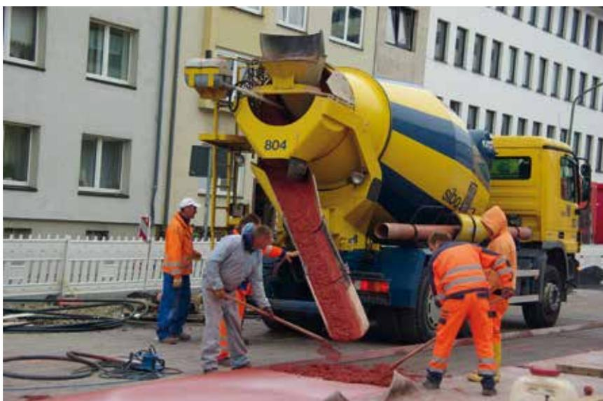
**Bild 4: Einbau des pigmentierten Betons**
