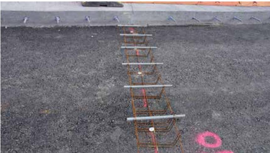
**Bild 4: Einbau der Dübel auf Stützkörpern**
