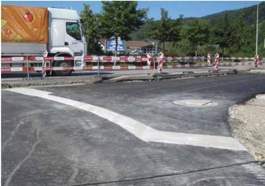
**Bild 10: Beispiel einer Unterlagschwelle im Kreisverkehr**
