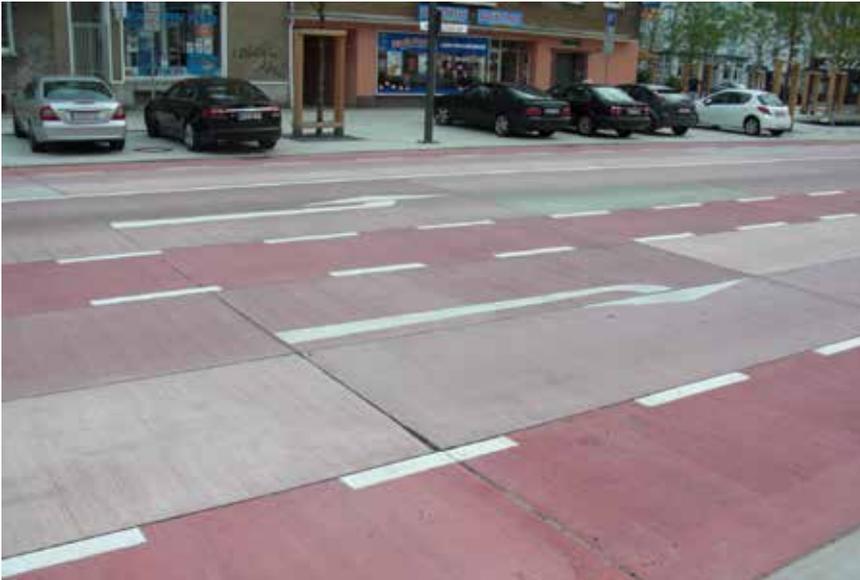
**Bild 5: Fertige Betonfahrbahnfläche**
