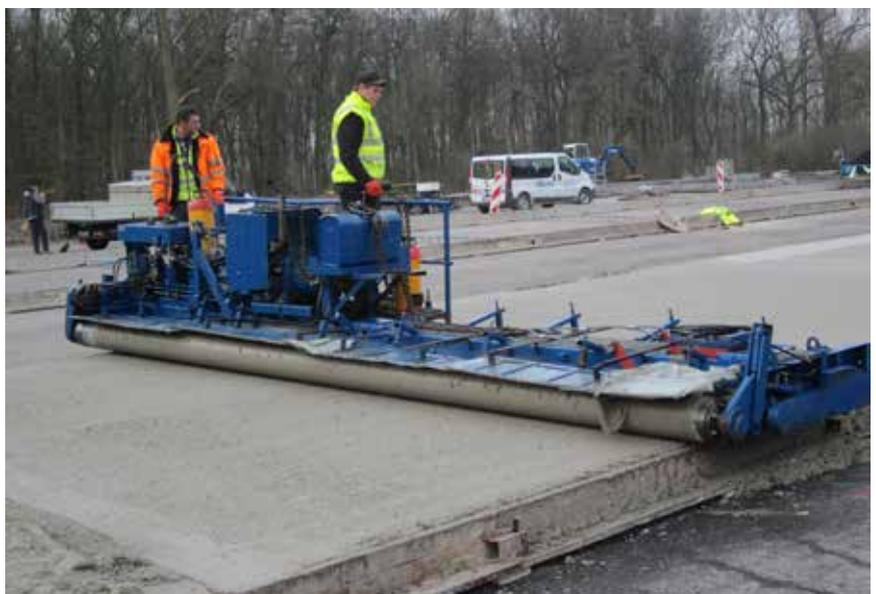
Bild 8: Einbau mit Walzenfertiger
