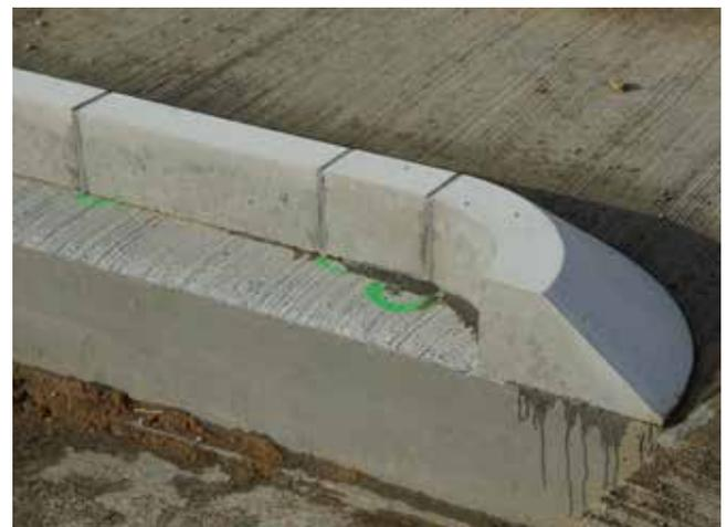
Bild 2: Aufgeklebter Bord
