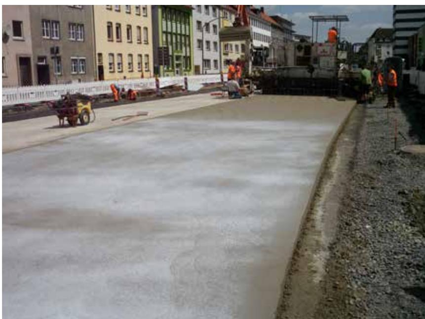
**Bild 3: Einbau des Unterbetons mittels Gleitschalungsfertiger**
