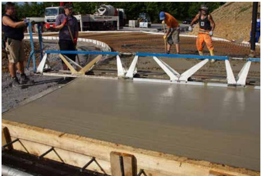
Bild 7: Einbau mit Rüttelbohle
