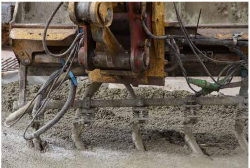
Bild 6: Verdichten mit Rüttelflaschen, befestigt an der Baggerschaufel
