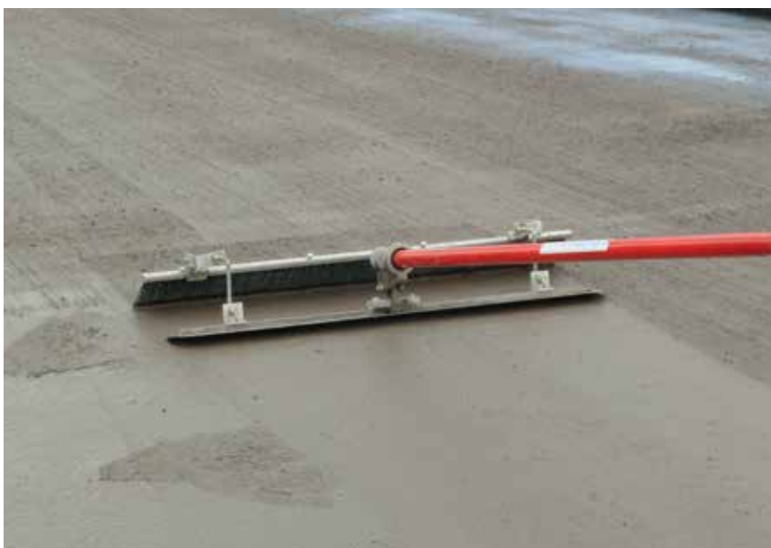
Bild 6: Herstellung der Oberflächentextur
