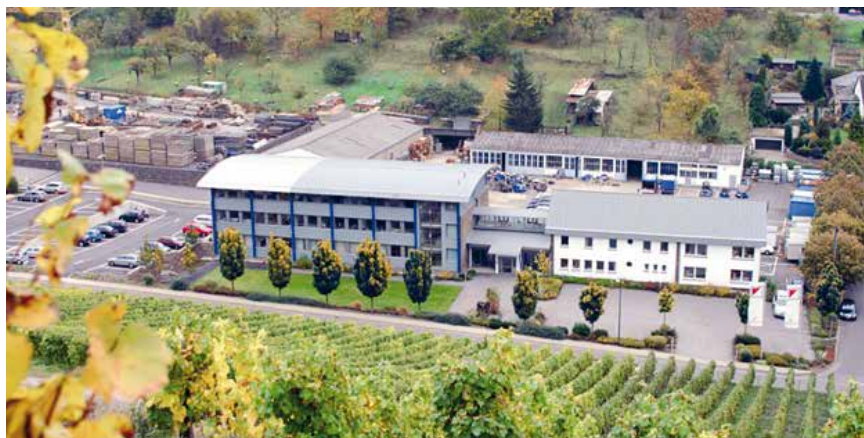
Hauptsitz der Heinz Schnorpfeil Bau GmbH in Treis-Karden
