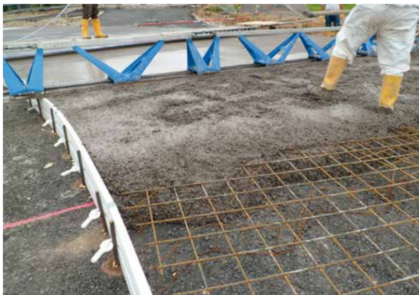
Bild 3: Schalung, Bewehrung und Verdichtung des Fahrbahndeckenbetons
