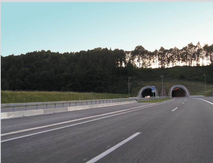
Heidkopftunnel (Tunnel der Deutschen Einheit) im Zuge der A 38
