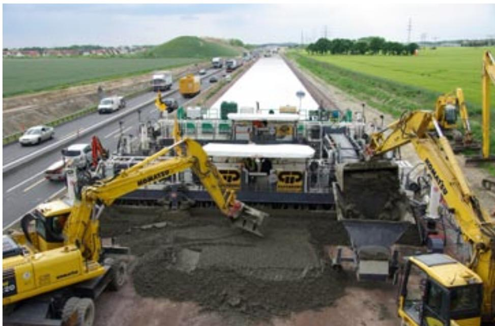
Gleitschalungsfertiger im Einsatz für eine qualitätsgerechte Herstellung einer Betonfahrbahndecke.
