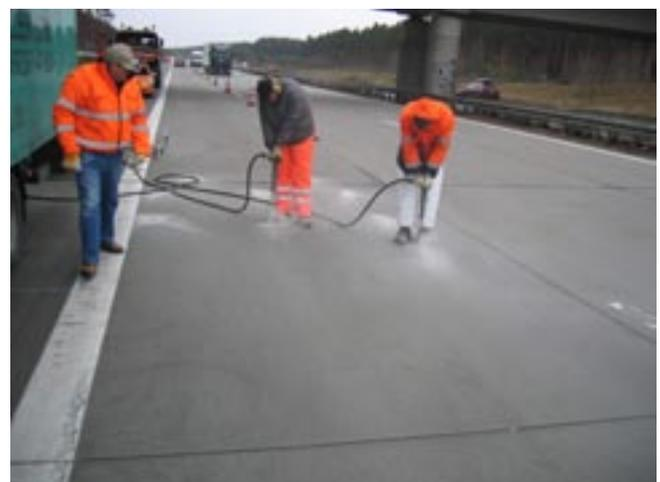
Bild 2: Herstellung der Bohrlöcher von Hand
