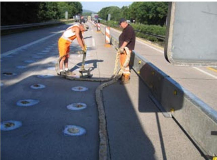
Bild 3: Unterpressen mit expandierendem Polyurethanharz
