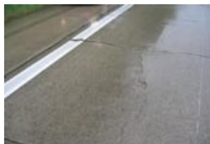
**Bild 2:** Stark geschädigte Fahrbahnplatte aus Beton
