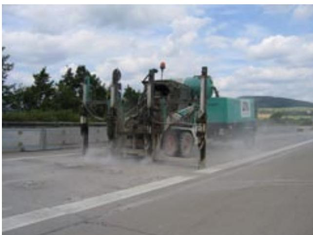
Bild 1: Maschinelle Herstellung der Bohrlöcher
