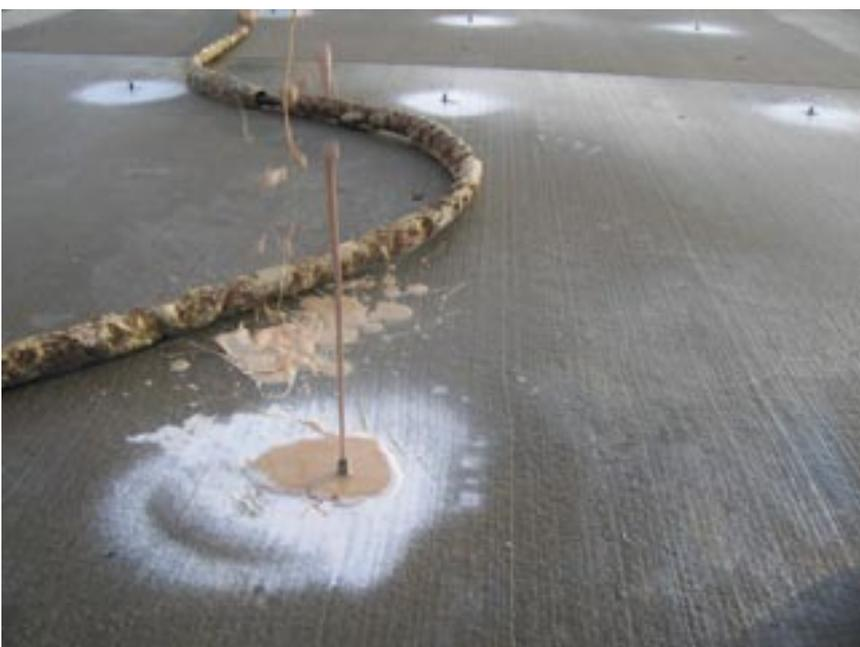
Bild 4: Austreten von Injektionsmaterial an benachbarten Injektionslöchern
