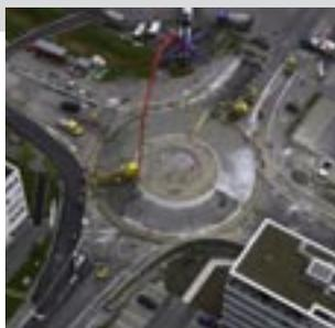
Der bei 10 m Einbaubreite 22 t wiegende Kreiselfertiger fährt auf vier automatisch nachlenkenden Raupenfahrwerken und kann so einen Vollkreis mit exakter Überdeckung ausführen. Die Einbaubreite lässt sich je nach Größe des Kreisverkehrs in 5cm-Schritten zwischen 2,5 und 11 m einstellen. Einsetzbar ist der Fertiger ab 5m innerem Radius.
