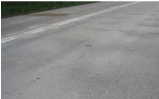
Bild 4: Stark geschädigte Fahrbahnplatte aus Beton nach dem Unterpressen mit Kunstharz
