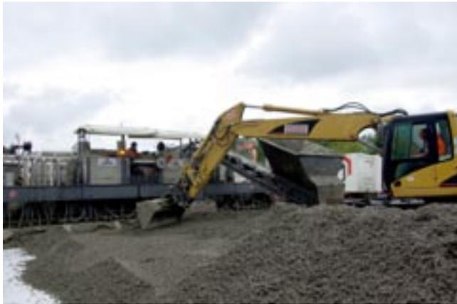
Einbringen des Unterbetons mittels Gleitschalungsfertiger
