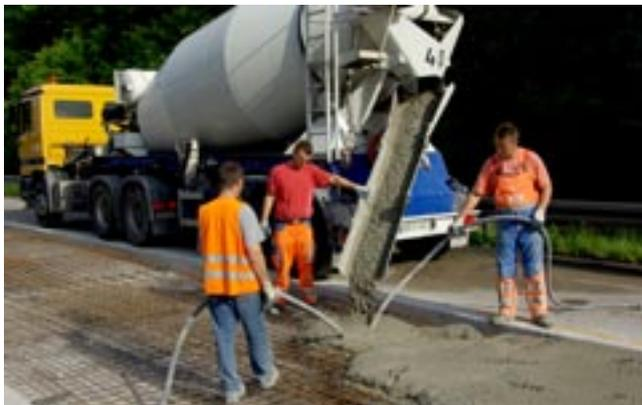
Einbringen des Betons aus dem Fahrmischer und Verdichten
