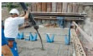
Ebenheitstoleranzen nach DIN 18202 Zeile 4 sind realisierbar. Die Vortriebsgeschwindigkeit des Beldor-Fertigers beträgt bis zu einem Meter pro Minute.
