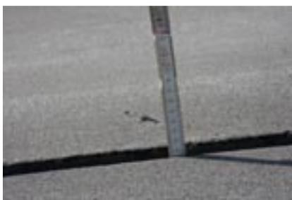
**Bild 1:** Stufenbildung bzw. vertikaler Plattenversatz an einer Querfuge und schadhafte Fugenfüllung
