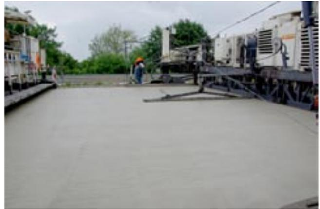
Herstellen der Oberfläche mittels Längs-/Querglätters
