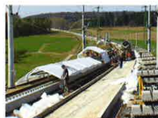
Einbau von Füllbeton zum Fixieren der Schwellen in freier Strecke
