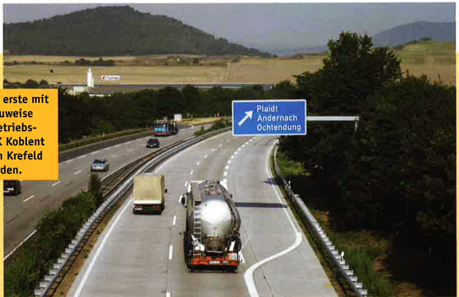
Bild unten: Fahrbahndecken aus Beton sind auch für Ortsumgehungen eine wirtschaftliche, dauerhafte, verkehrssichere und geräuscharme Realisierungsvariante.
