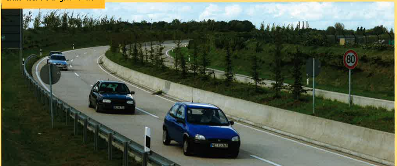
Bild unten: Fahrbahndecken aus Beton sind auch für Ortsumgehungen eine wirtschaftliche, dauerhafte, verkehrssichere und geräuscharme Realisierungsvariante.
