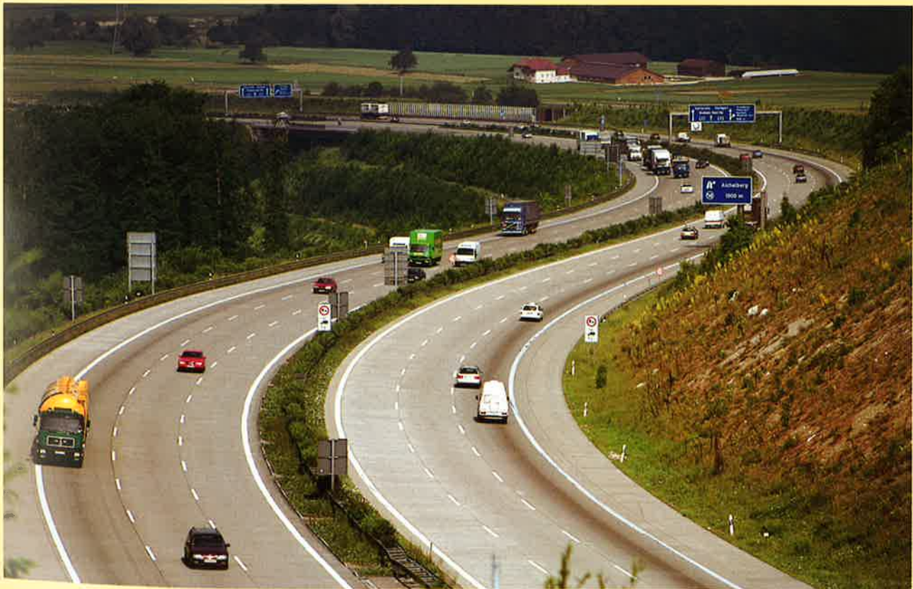
BAB A 8 Aichelbergaufstieg bei KirchheimTTeck: Selbt in hügeligem Gelände sind ebene Beton- fahrbahndecken realisierbar.
