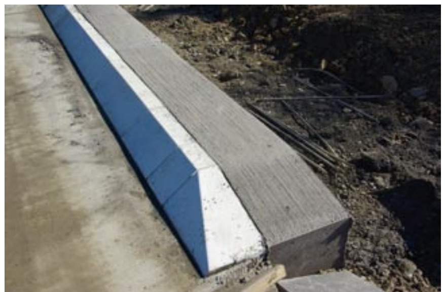
Bild 6: Aufgeklebter Bordstein mit Betonriegel
