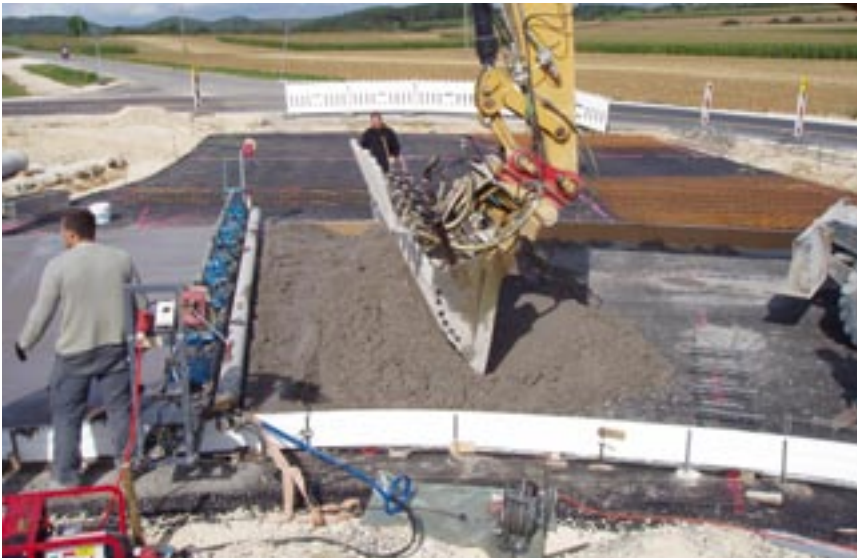
Bild 7: Verdichten und Abziehen des Betons mittels Rüttelflaschen am Bagger und einer Rüttelbohle
