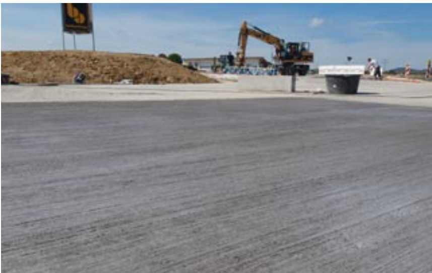
Bild 8: Oberflächentexturierung mit Besenstrich für eine ausreichende Griffbarkeit
