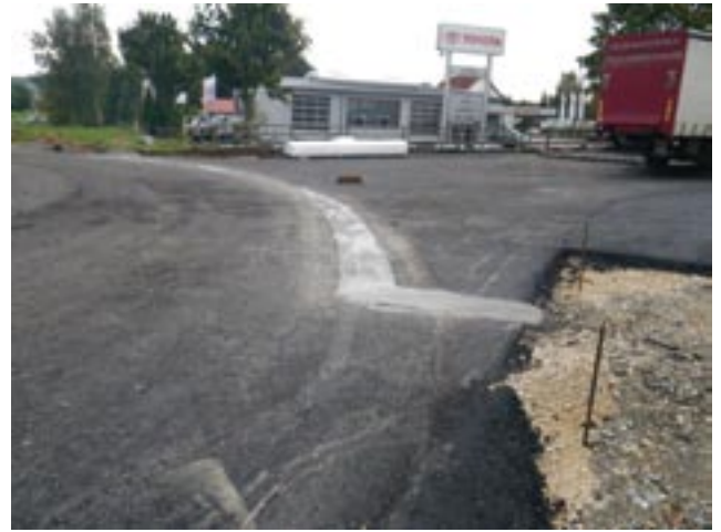
Bild 5: Auflagerbalken aus Beton in der Asphalttragschicht
