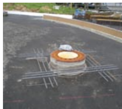
Bild 3: Bewehrungszulagen im Bereich von Einbauten
