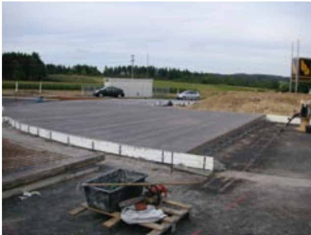
Bild 4: Raumfuge mit betonierter erster Kreisfahrbahnfläche
