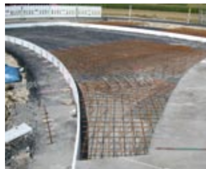
Bild 2: Bewehrungszulagen in den Ein- und Ausfahrtsbereichen
