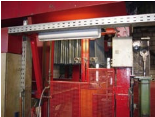
Bild 1: Aufbringen der Kunststoffbeschichtung für Dübel
