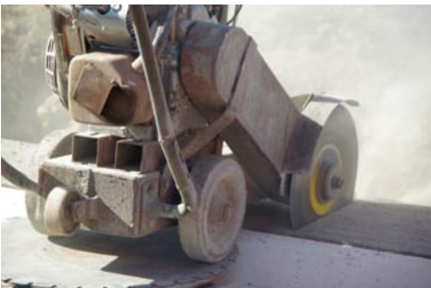
Bild 9: Schneiden der Fugen in der Bordanlage
