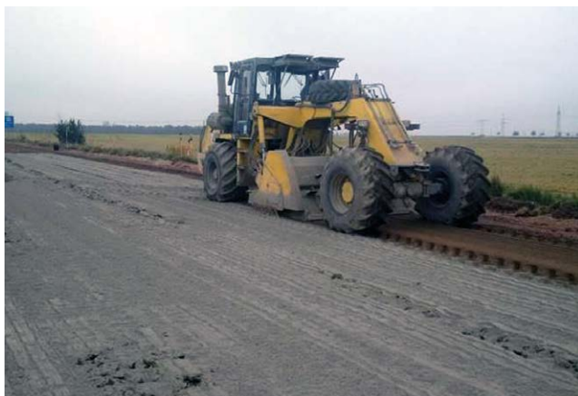
Bild 3: Arbeitstakt Bodenbefestigung
