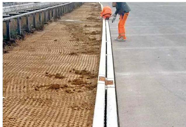
Bild 4: Arbeitstakt Mittelstreifenentwässerung
