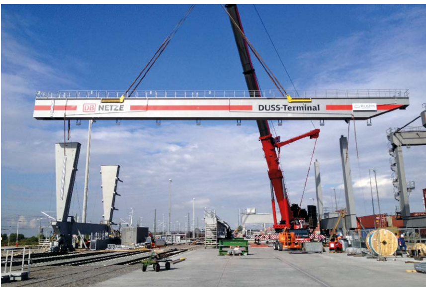
Bild 1: Betonflächen unter Portalkran
