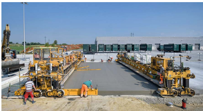
Bild 7: Einbau einer Betondecke
