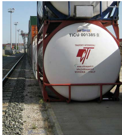
Bild 4: Ungünstige Abstellpositionen am freien Plattenrand und mit Containerfüßen im Fugenbereich
