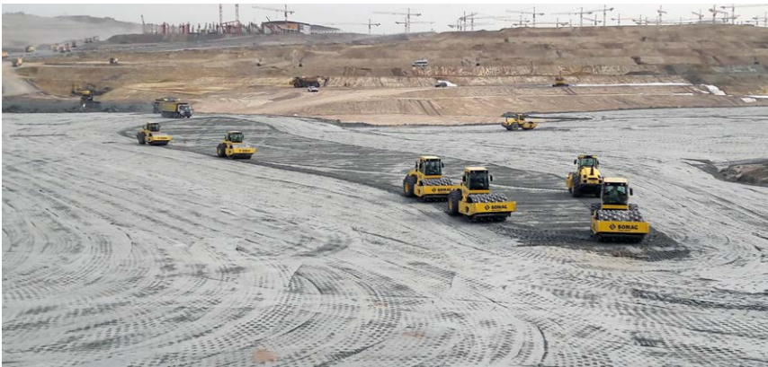
Bild 8: Walzschema für sechs im Kreis fahrende Walzenzüge
