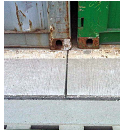
Bild 4: Ungünstige Abstellpositionen am freien Plattenrand und mit Containerfüßen im Fugenbereich
