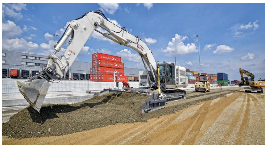
Bild 6: Einbau einer hydraulisch gebundenen Tragschicht
