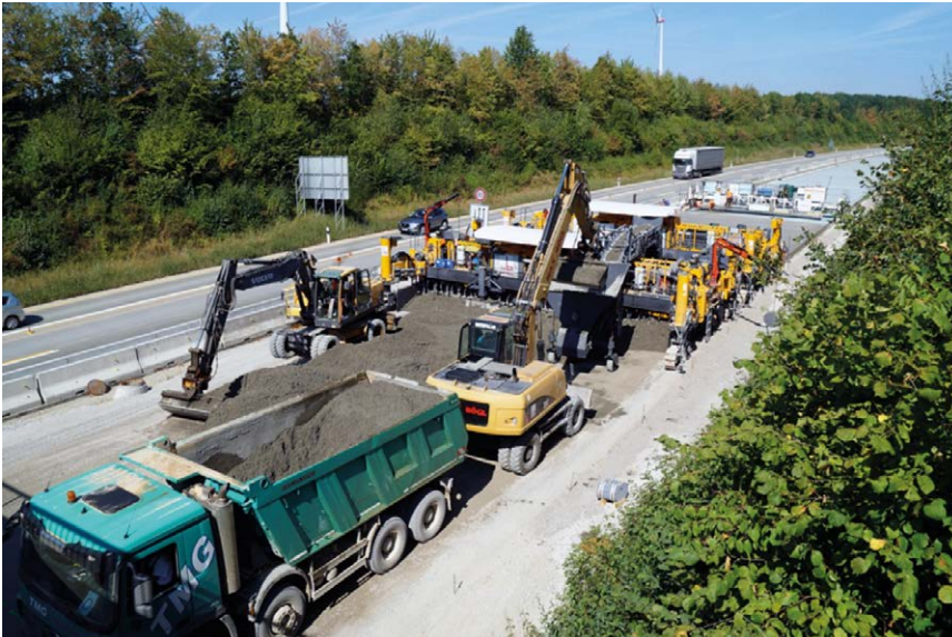
Bild 5: Betonversorgung eines Straßendeckenfertigers
