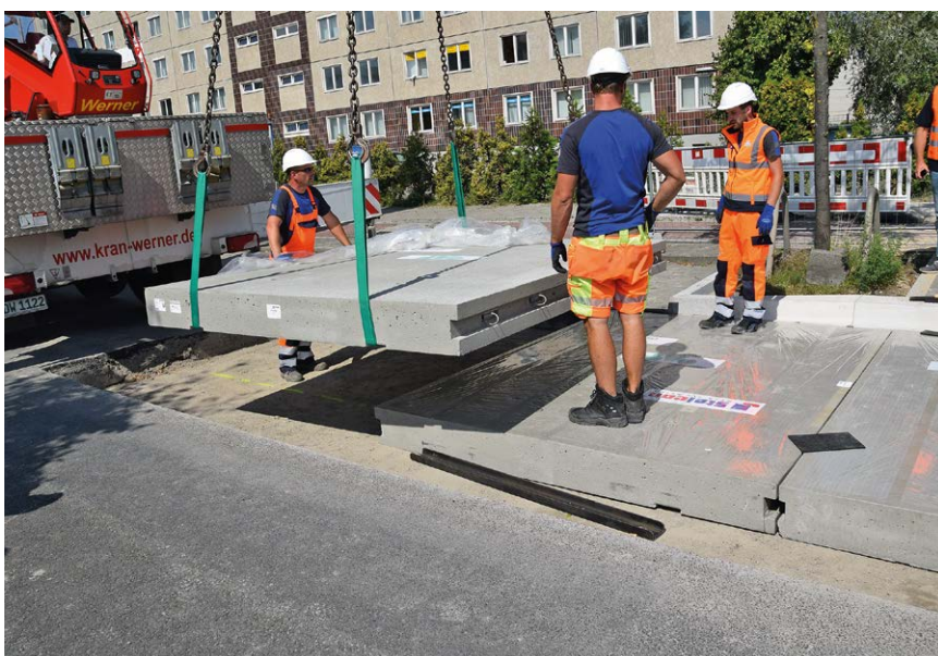
Bild 9: Verlegung mit Hilfe von Stahlseilen und Schwerlastankern und mittels Hochleistungsgurtbändern
