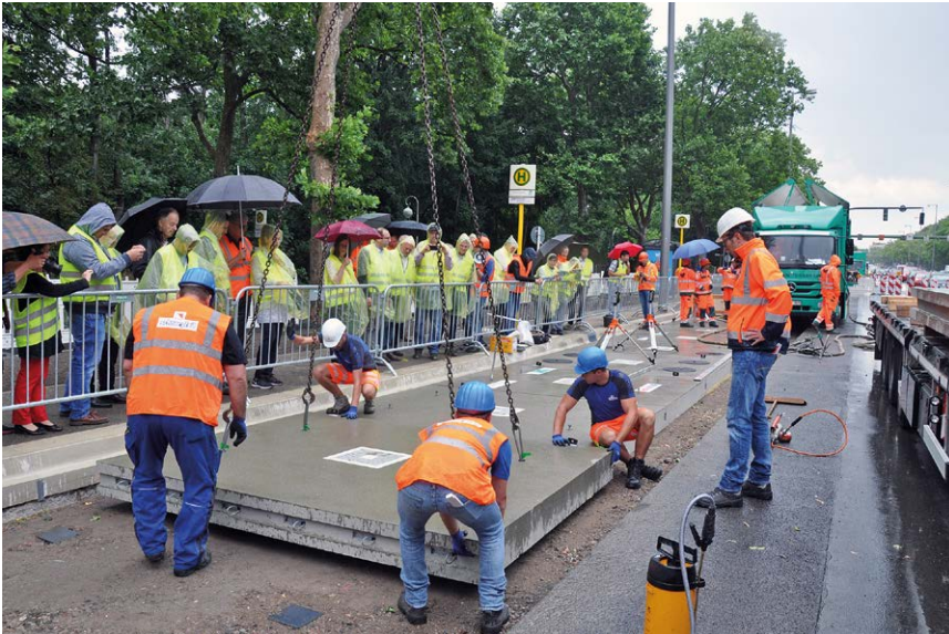
Bild 14: Besucher des Internationalen Betonstraßensymposiums beim Fertigteileinbau
