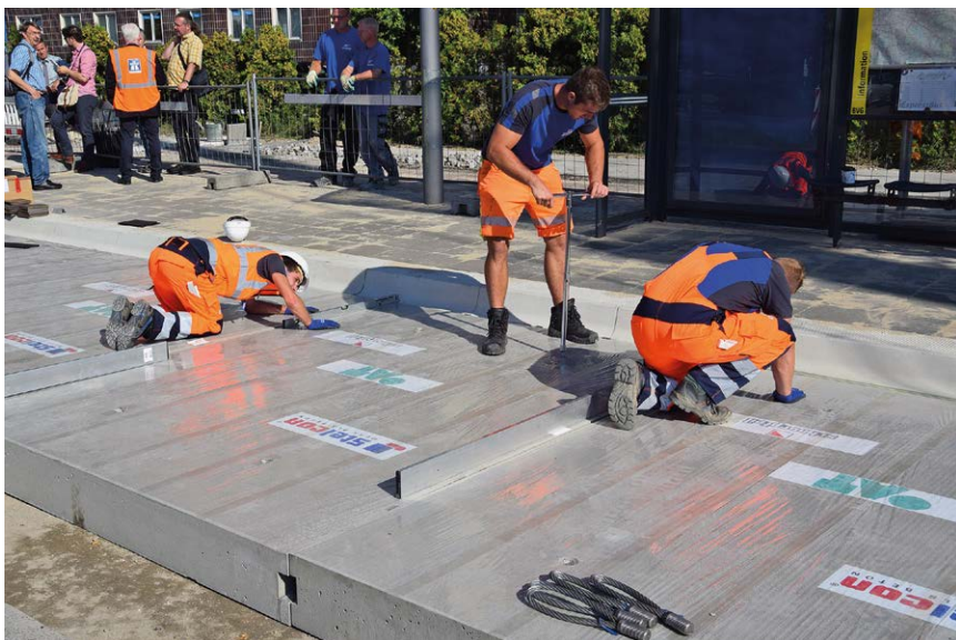
Bild 8: Ausrichtung und Höhenjustierung der Fertigteile
