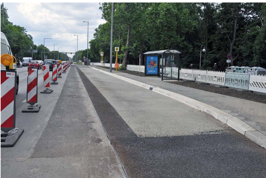
Bild 16: Fertiggestellte Bushaltestelle mit Fertigteilen
