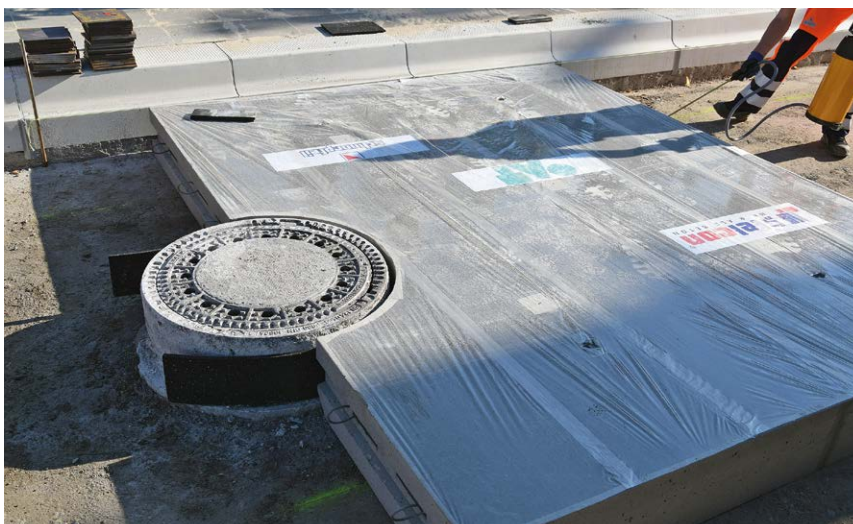
Bild 7: Fertigteil am Schacht und Nut-Nut-Konstruktion
