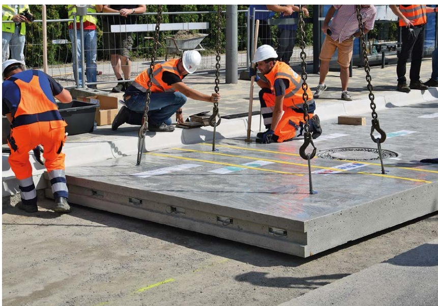
Bild 8: Ausrichtung und Höhenjustierung der Fertigteile
