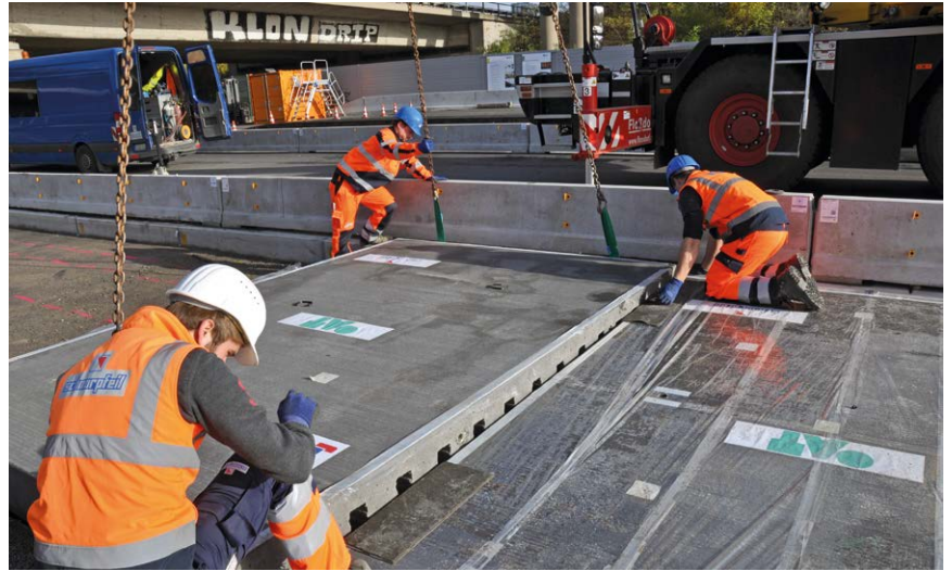
Bild 6: Fertigteil mit eingesetzten Dübeln (Dübel-Dübelkammer-System)
