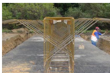
Abbildung 2.4: Endsporn, Bewehrungskorb und Aushub
