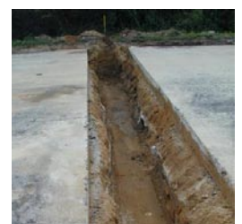
Abbildung 2.4: Endsporn, Bewehrungskorb und Aushub
