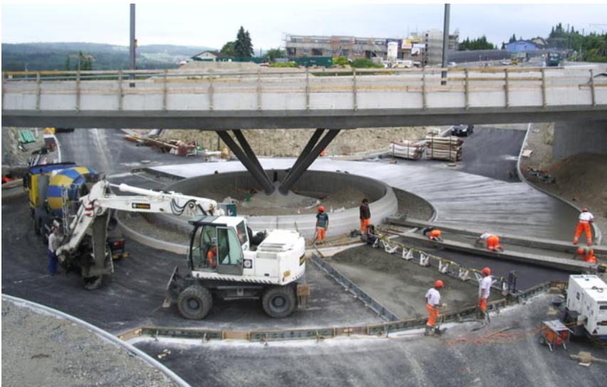
Kreisel Zufahrt Brenngarten AG, Handeinbau
