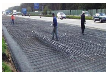
Abbildung 2.3: Vorgefertigte Längs- und Querbewehrung
