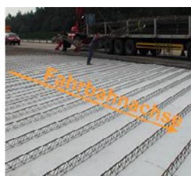
Abbildung 2.3: Vorgefertigte Längs- und Querbewehrung
