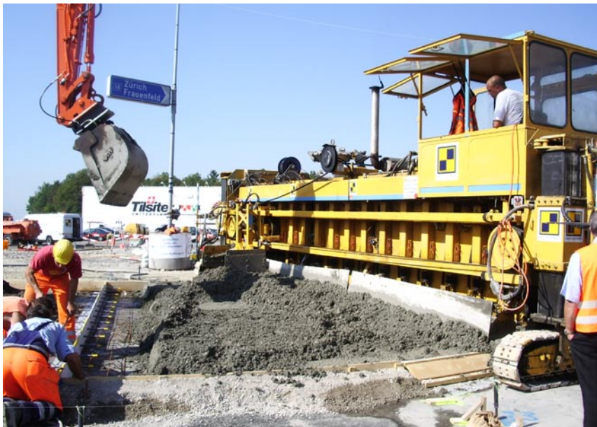
Kreisel Zeigli Weinfeld TG, maschineller Einbau
