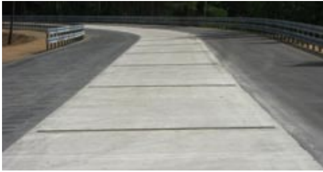
Beton mit querliegender Eisenbahnschiene gemäß Pkt. 4
