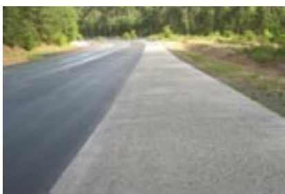
Ergebnis Beton gemäß Pkt. 2
