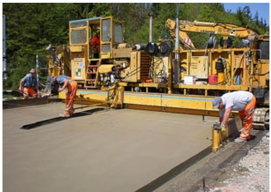
Bild 4: Betoneinbau mit Gleitschalungsfertiger
