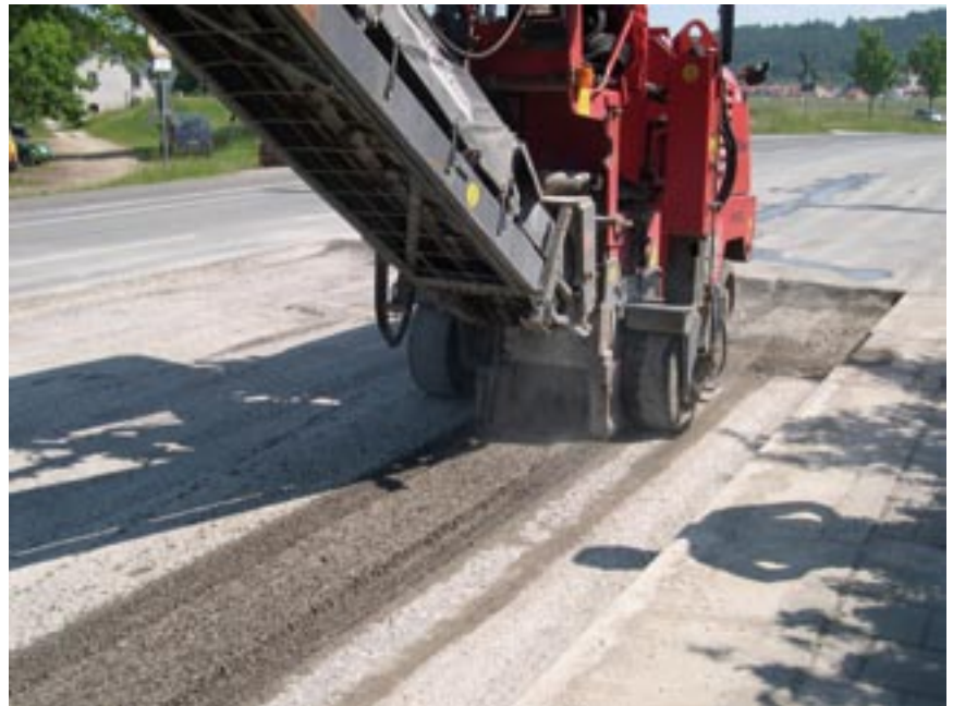
Bild 3: Fräsen des Asphalts
