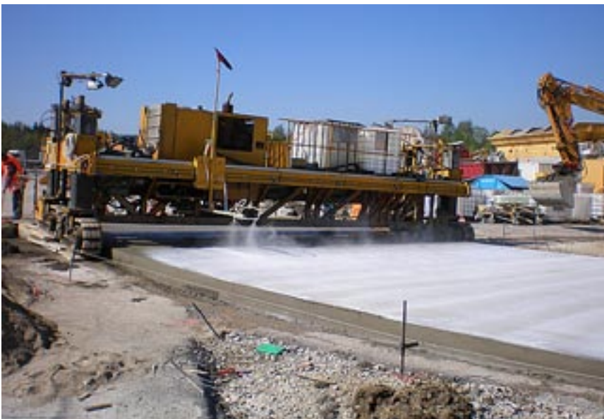
Bild 5: Aufspritzen des Oberflächenverzögerers
