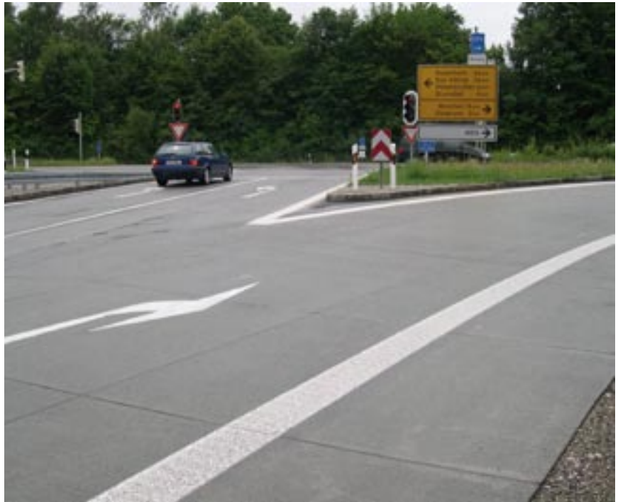
Bild 7: Fertiggestellte Abfahrtsrampe an Lichtsignalanlage
