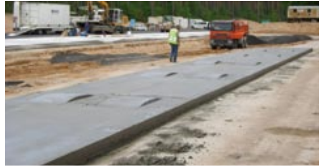
Beton mit Buckel gemäß Pkt. 5
