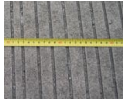
Anforderung Beton mit Querrillen gemäß Pkt. 1
