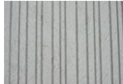
Ergebnis Beton mit Querrillen gemäß Pkt. 1
