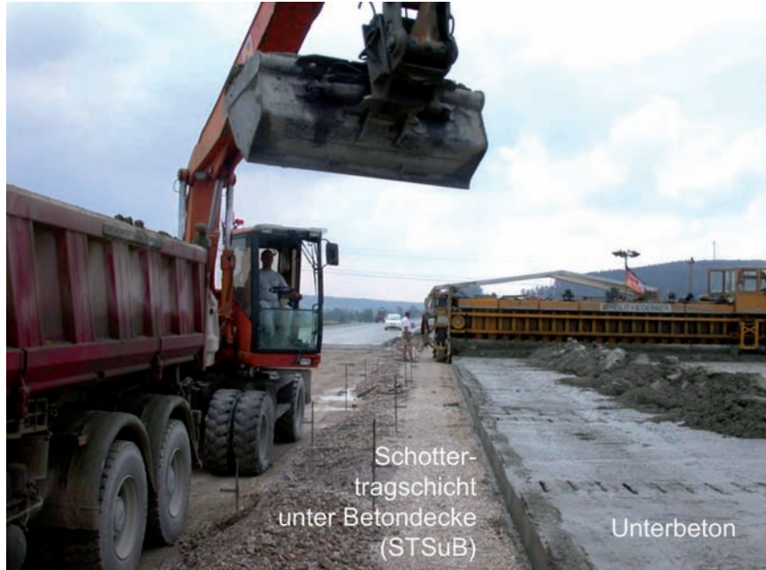
Bild 1: Einbau einer zweischichtigen Betondecke auf STSuB mit einem Betondeckenfertiger
