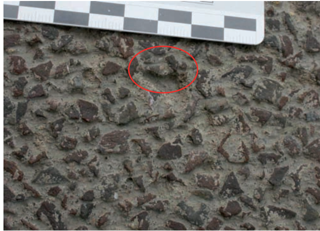
Abb. 16 u. 17: Ausgeprägtes und nicht ausgeprägtes Ausbruchverhalten auf Betondecken mit CEM I-Zement
