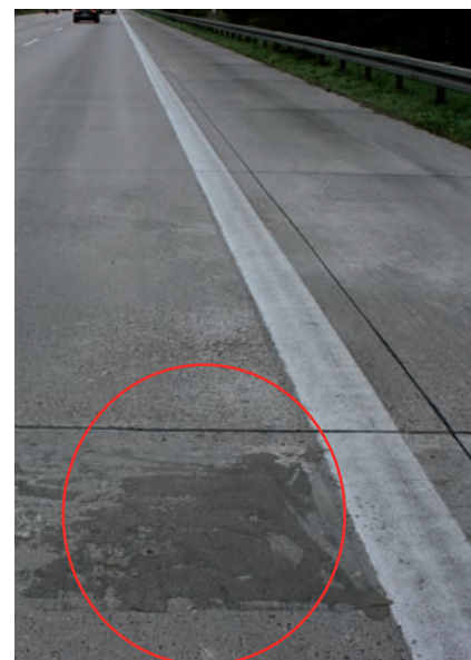
Abb. 6 bis 8: Abplatzungen an einer Betonoberfläche im Standstreifen (Bilder links), Fehlstelle (Bild rechts)
