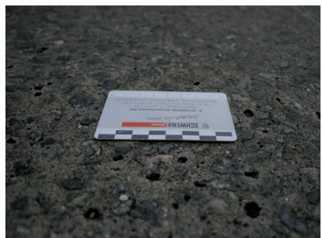
Abb. 13 und 14: Luftporen an der Betonoberfläche (links CEM I Waschbeton nach ca. 2 Jahren und rechts CEM II-Beton mit Besenstrich nach ca. 30 Jahren)
