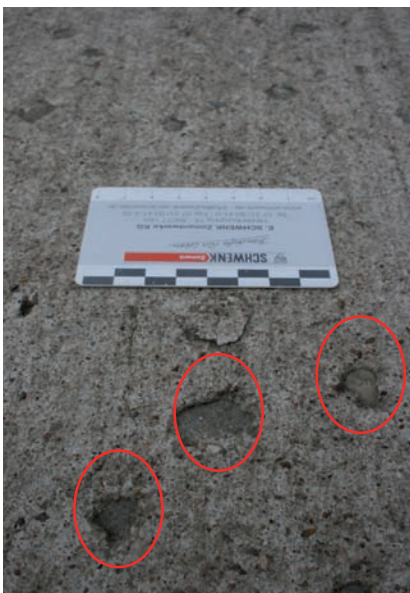
Abb. 6 bis 8: Abplatzungen an einer Betonoberfläche im Standstreifen (Bilder links), Fehlstelle (Bild rechts)
