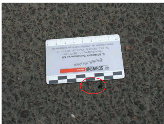
Abb. 13 und 14: Luftporen an der Betonoberfläche (links CEM I Waschbeton nach ca. 2 Jahren und rechts CEM II-Beton mit Besenstrich nach ca. 30 Jahren)
