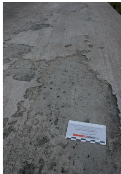
Abb. 6 bis 8: Abplatzungen an einer Betonoberfläche im Standstreifen (Bilder links), Fehlstelle (Bild rechts)
