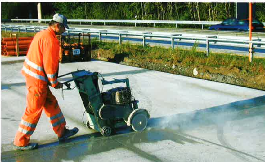
Abfasen der Fugenkante
