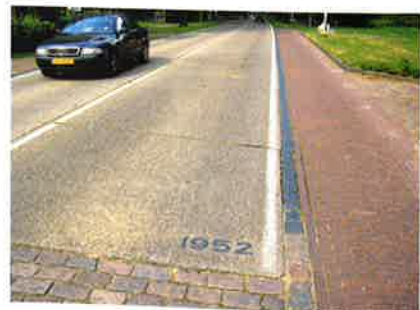
Eine in 1952 eingebaute Betonstraße (immer noch in einem guten Zustand)
