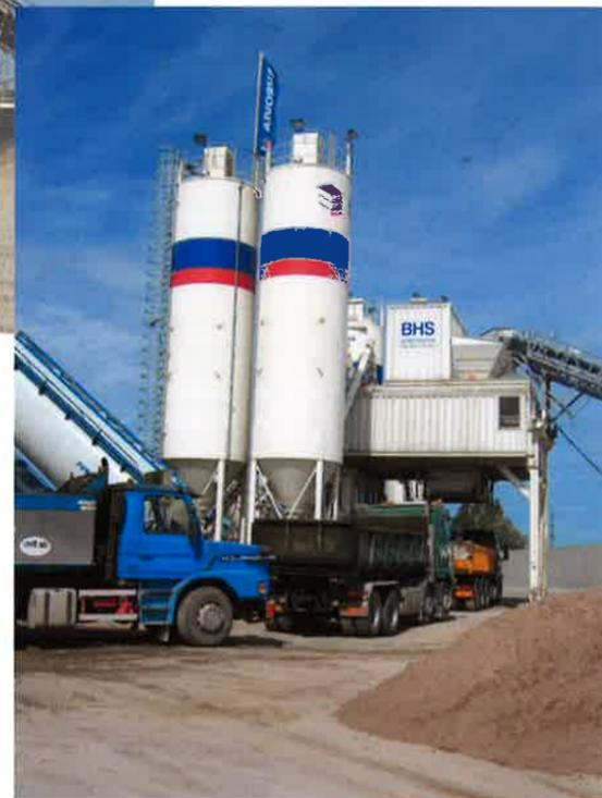
Die Anlage mit zwei Doppelwellenmischern wurde nahe der Baustelle aufgebaut. Diese Betonmischanlage besteht aus mehreren Containerelementen. Die maximale Mischleistung beträgt 250 m<sup>3</sup> Beton pro Stunde.
