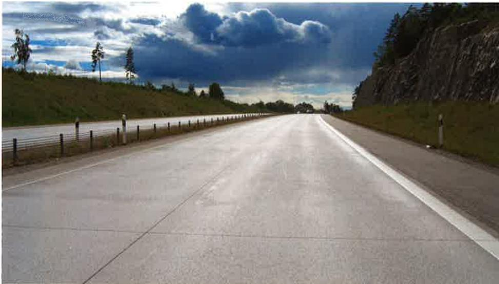
Washbetonoberflächen sind leise und trotzdem stark belastbar. Sie ermöglichen eine dauerhaft gute Griffigkeit. In zahlreichen europäischen Ländern – hier z.B. beim Bau der E4 in Schweden – wird diese Bauweise bereits mit Erfolg angewandt. Foto: Otto Alte-Teigeler GmbH
