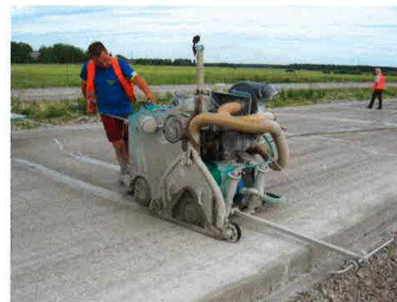
Schneiden der Fugen für eine kontrollierte Rißbildung und als Vorbereitung der Fugenherstellung
