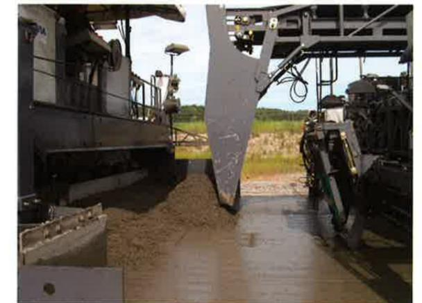
Der Oberbetonfertiger des SP 1500 fertigt die 50 mm Oberbeton und glättet die Oberfläche. Das Größtkorn im Oberbeton ist 16mm.
