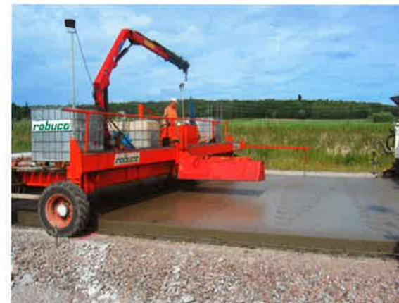
Ein Verzögerer wird unmittelbar danach auf die Betondecke aufgesprüht, um die Aushärtung der Oberfläche zu verhindern.
