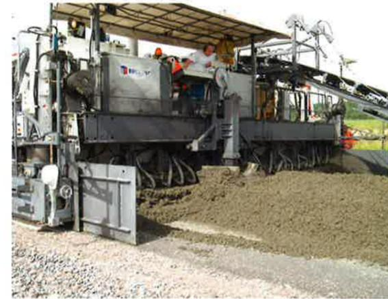
Der Unterbetonfertiger des SP 1500 verteilt die 150 mm Unterbeton und verdichtet ihn mit seinen Rüttelflaschen. Die maximale Größe des Splitts im Unterbeton beträgt hierbei 32 mm.
