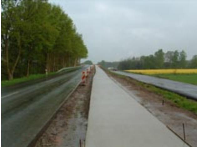
**Bild 4:** Fahrradwege lassen sich in Gleitschalungstechnik schnell herstellen.
