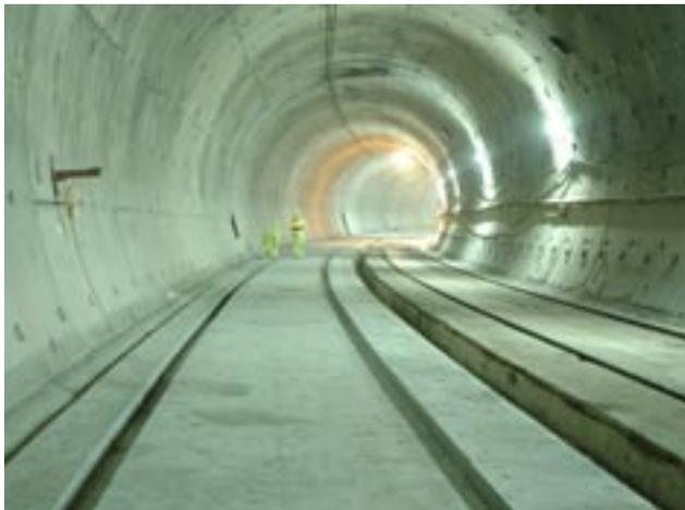
**Bild 6:** Feste Fahrbahn in einem Schnellbahntunnel. Beide Fahrspuren werden als separate Betonprofile eingebaut.
