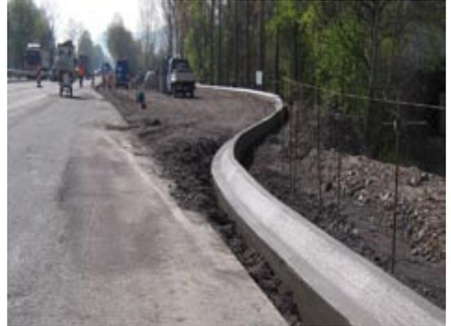
**Bild 5:** Kontinuierlich hergestellter Bordstein entlang einer Parkbucht mit engen Radien
