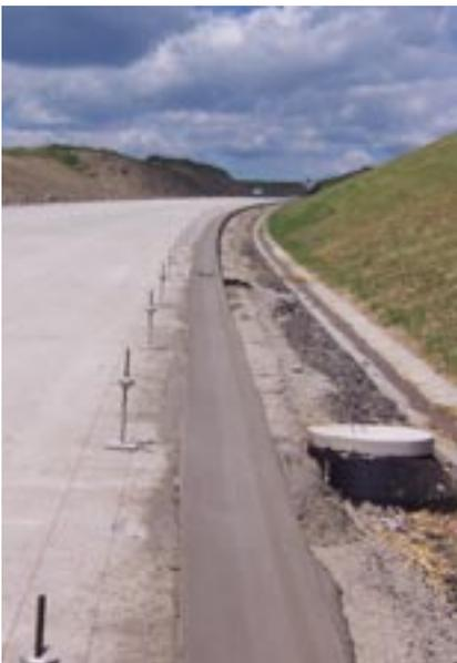
**Bild 3: Entwässerungsrinne entlang einer Autobahn-Neubaustrecke**
