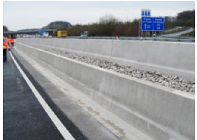
**Bild 7:** Sichere Abtrennung der Richtungsfahrbahnen einer dicht befahrenen Autobahn mit Ausgleich des Höhenunterschiedes
