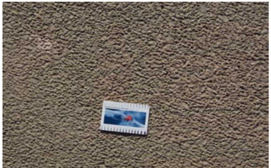
**Bild 5: Waschbetonoberfläche mit einem CEM III/A 42,5 N**
