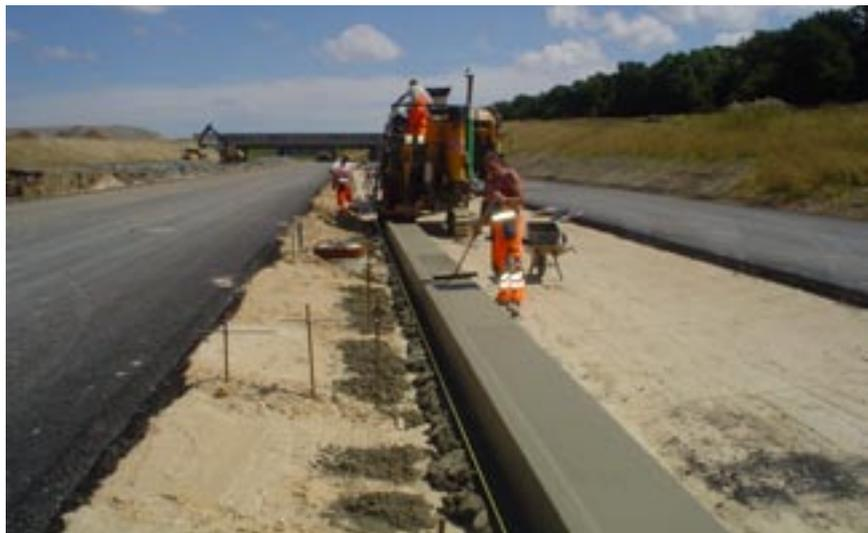
**Bild 2: Herstellung einer Bord-Rinnen-Kombination**
