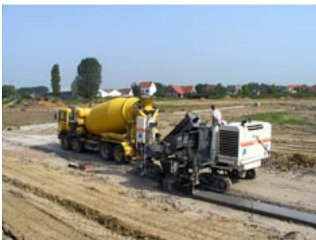
**Bild 8:** Der Betoneinbau mit dem Gleitschalungsfertiger ist ein kontinuierlicher Prozess. Vom Fahrmischer gelangt der Beton über Förderschnecken in die Schalung, während der Fertiger stetig einbaut.
