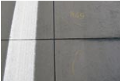
Bild 5: vereinzelte Schrägrisse im Fugenkreuz zwischen Last- und Standspur im Applikationsbereich der Hydrophobierung OS-A (02/2011)
