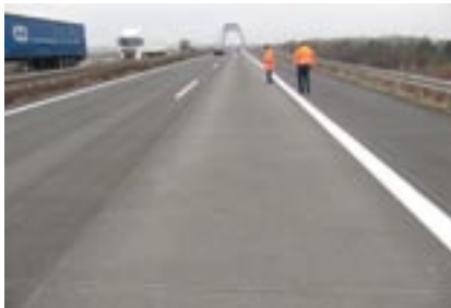
Bild 8: Übersichtsaufnahme im Bereich der Epoxidharzbeschichtung (01/2011)
