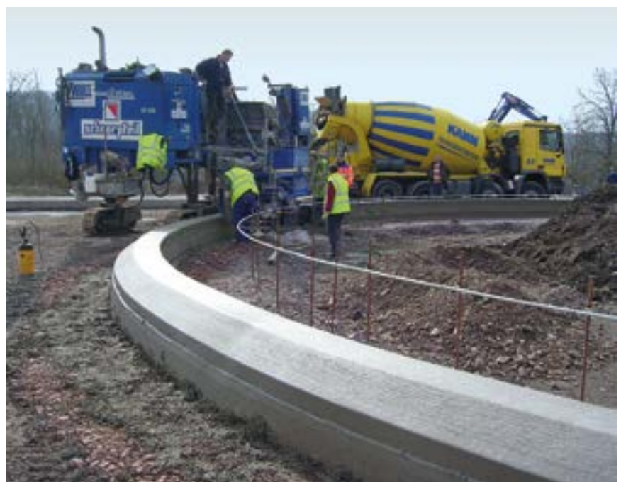
Bild 7: Bau einer Bordrinne mit Gleitschalungsfertiger
