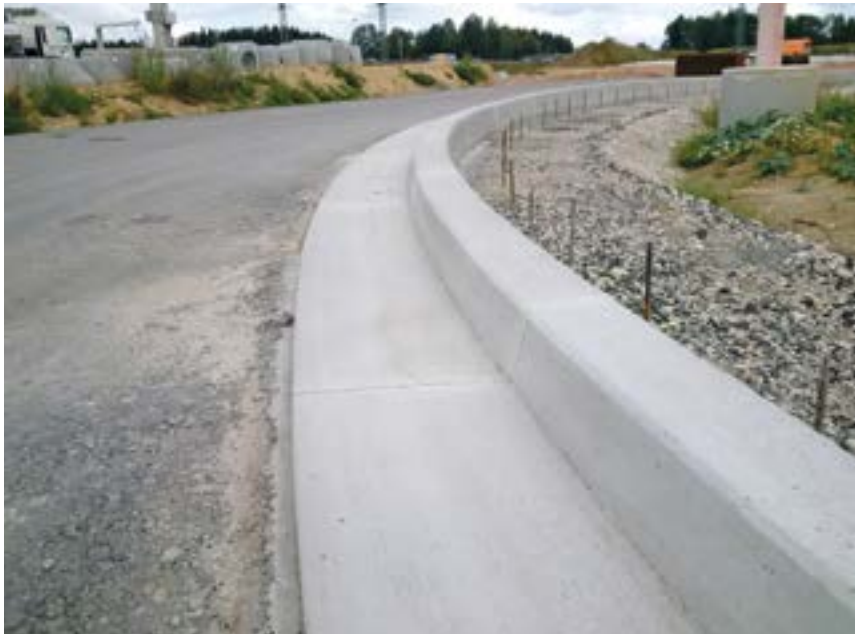
Bild 2: Monolithische Bord-Rinnen-Anlage aus einem Beton
