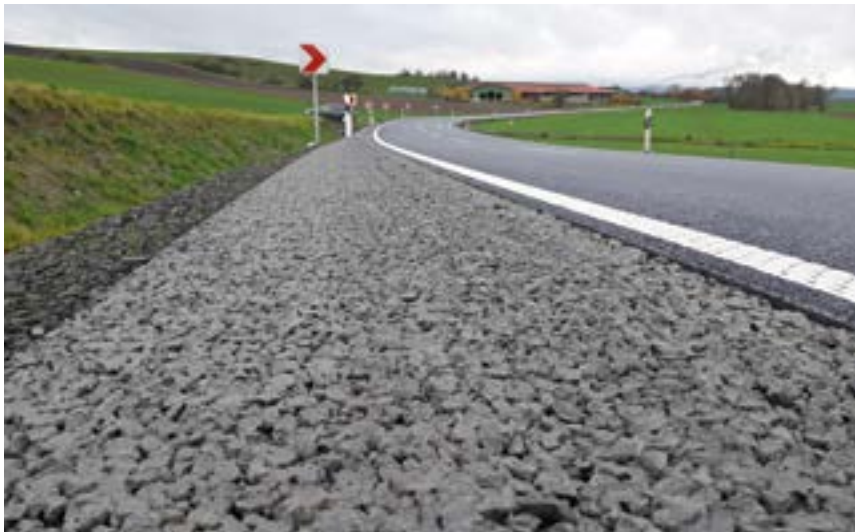
Bild 9: Dauerhafte, wasserdurchlässige Bankette aus polymermodifiziertem Beton
