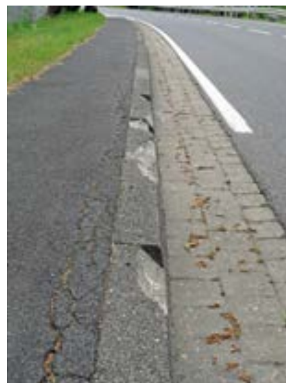
Bild 1: Konventionelle Bord-Rinnen-Anlage aus einzelnen Betonwaren
