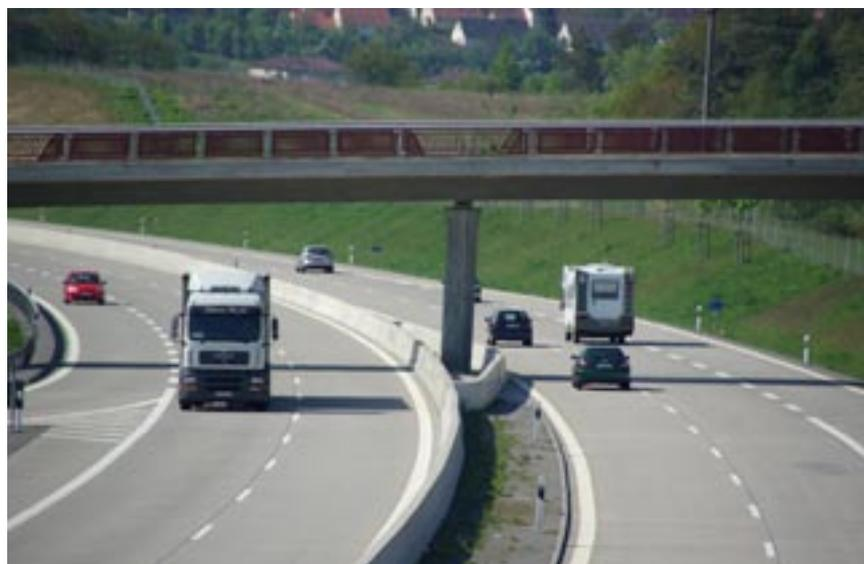
Fahrbahndecke aus Beton mit Betonschutzwand
