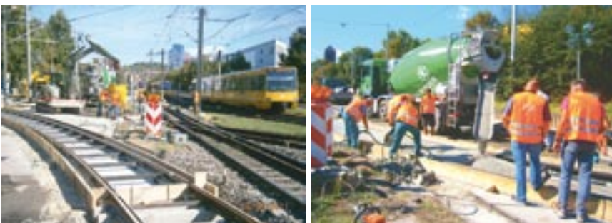
Bild 7: Stadtbahn U7, Stuttgart, Gleiseinbau Überfahrt B 27
