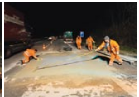
Bild 11: BAB A6, Fahrbahnplattenersatz im Bereich AS Mannheim-Rheinau – AS Schwetzingen
