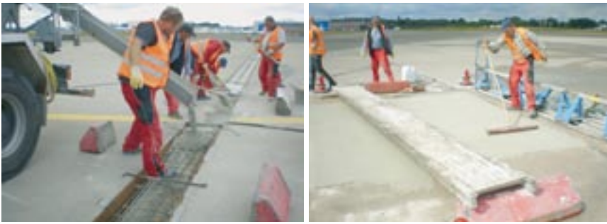
Bild 4: Flughafen Köln-Bonn, Schlitzrinnenreparatur und Fahrbahnplattenersatz
