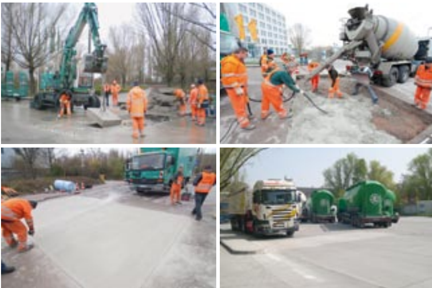
Bild 6: Zementwerk Leimen, Ersatz von Fahrbahnplatten auf der Zufahrt
