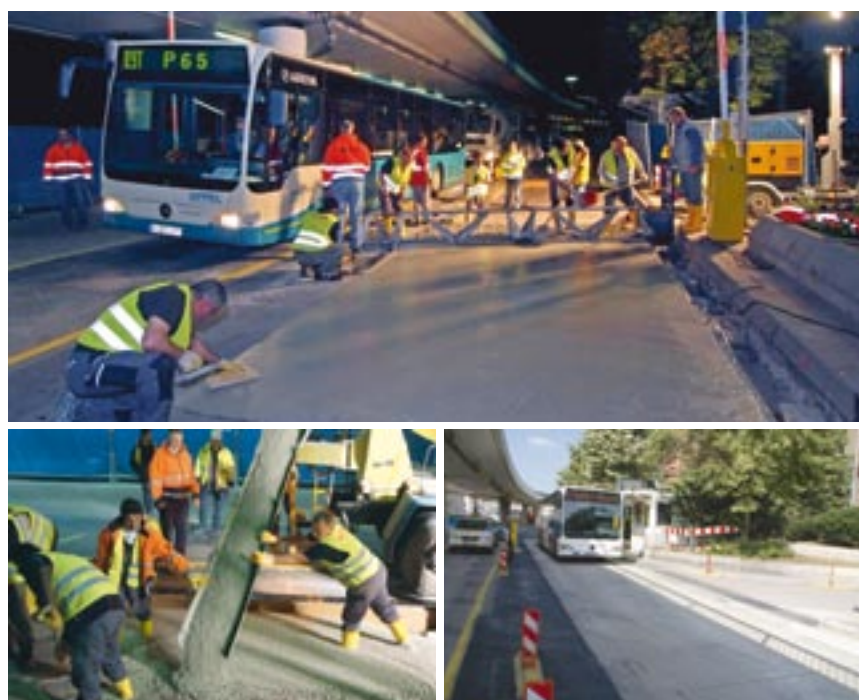
Bild 3: Flughafen Frankfurt, Teilstückerneuerung einer Pkw- und Busspur
