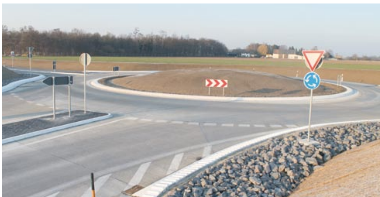
Bild 13: Kreisverkehr West vor Inbetriebnahme
