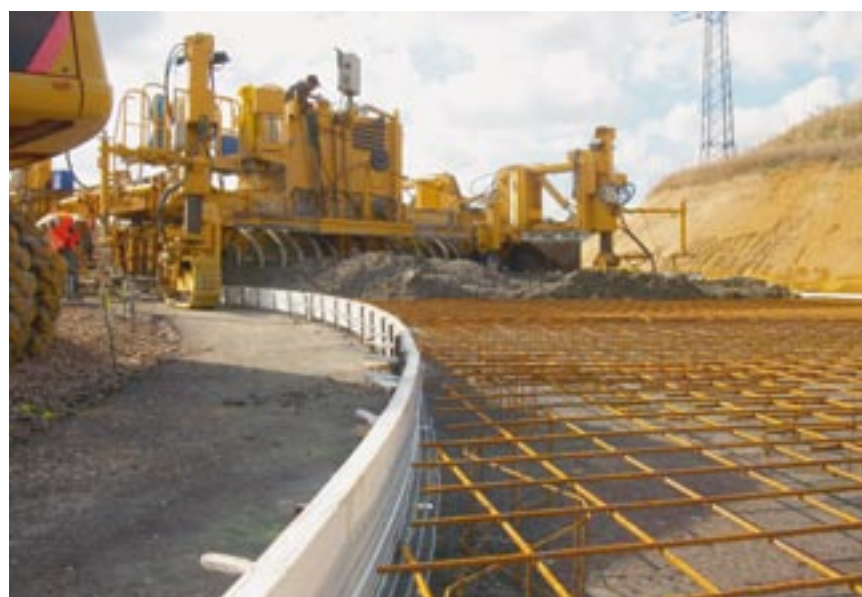
Bild 4: Bewehrung der Kreisfahrbahn mit nicht polygonaler Kunststoffschalung
