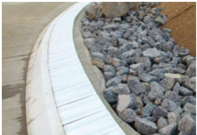
Bild 11: Klebebordstein mit Betonriegel
