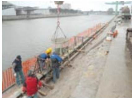
Bild 8: Osthafen Stuttgart, Erneuerung einer Kranbahn
