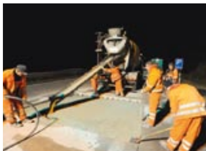
Bild 11: BAB A6, Fahrbahnplattenersatz im Bereich AS Mannheim-Rheinau – AS Schwetzingen
