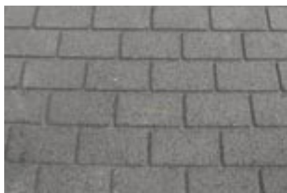
Bild 12: Präeasphalt innerhalb der Verkehrsteiler
