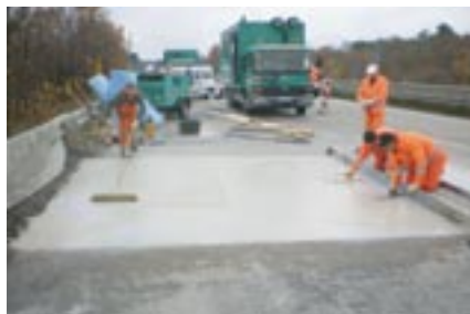
Bild 10: BAB A5, Verstärkung von vier Endplatten beim AK Darmstadt
