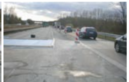
Bild 10: BAB A5, Verstärkung von vier Endplatten beim AK Darmstadt
