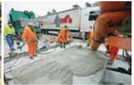
Bild 9: BAB A5, Erneuerung von drei Fahrbahnplatten beim AK Walldorf
