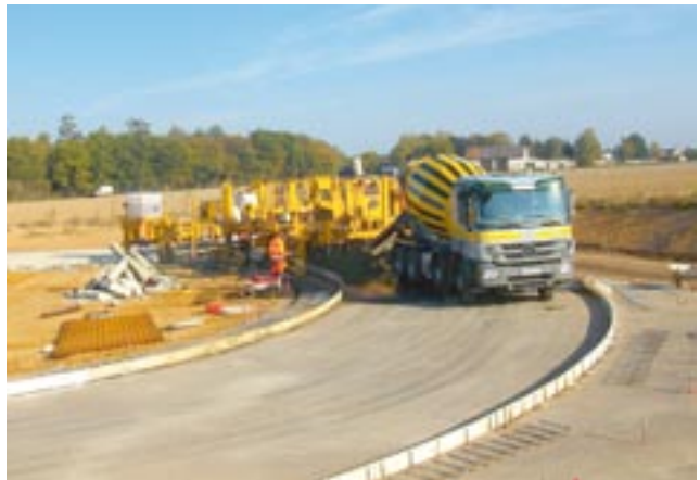
Bild 9: Faserbetoneinbau eines Kreissegmentbogens
