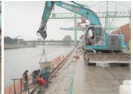
Bild 8: Osthafen Stuttgart, Erneuerung einer Kranbahn
