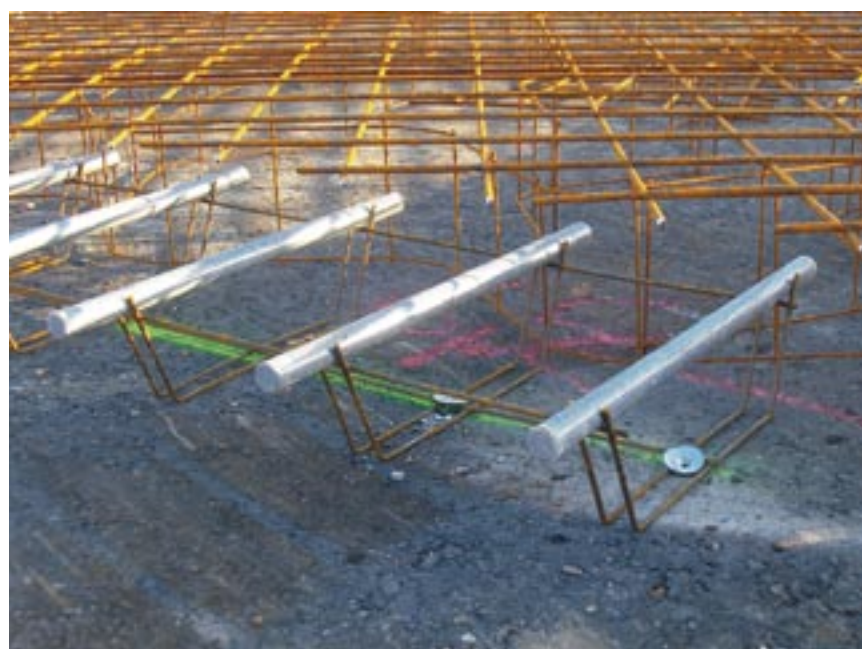
Bild 3: Dübels auf speziellen Tragekörben mit Fixierung auf der Asphalttragschicht
