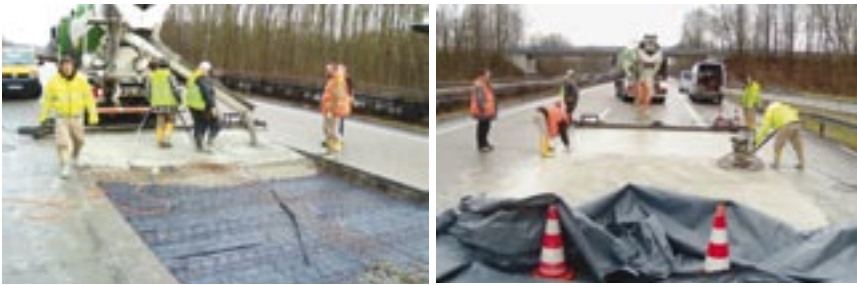
Bild 5: BAB A1, Plattenersatz im Bereich des AK Münster
