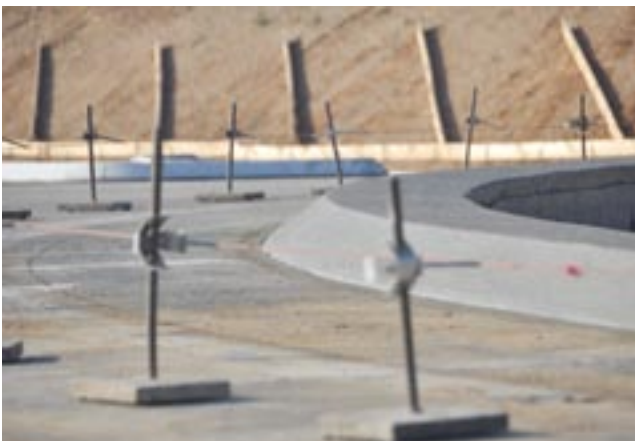
Bild 10: Eingebaute Bordanlage, ohne Fugenschnitt
