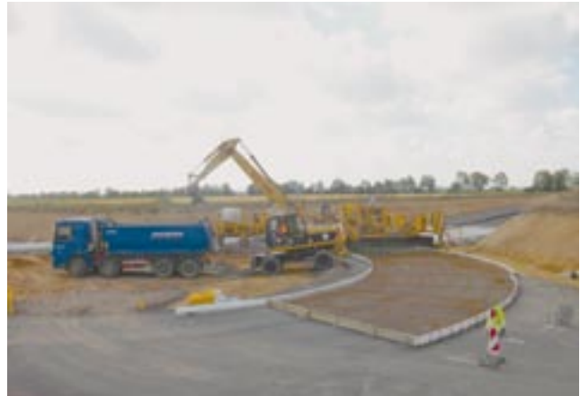
Bild 7: Grobverteilung des Betons vor Gleitschalungsfertiger
