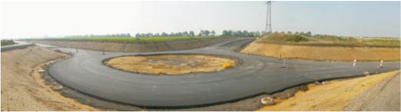
Bild 5: Kreisverkehr Ost vor Herstellung der Betondecke
