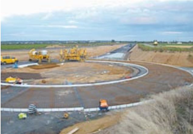
Bild 6: Vorbereitungsarbeiten für Betoneinbau
