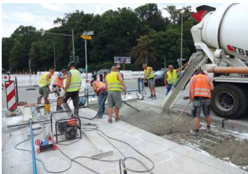
Bild 4: Einbau des Schnellbetons
