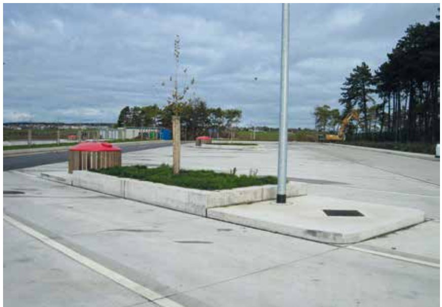
Bild 3: Zwischeninsel mit Hochbeet und Podesten aus Ort beton
