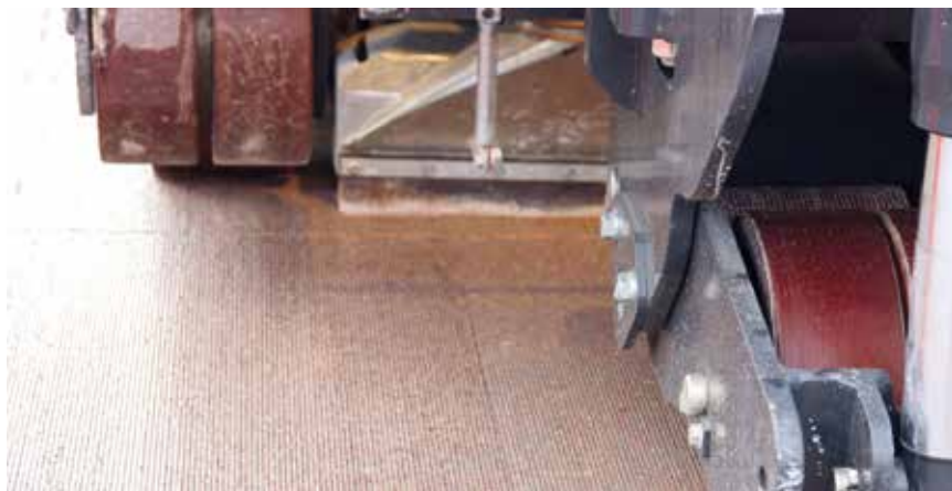
Bild 5: Grindung von Betonoberflächen zur Lärmreduzierung
