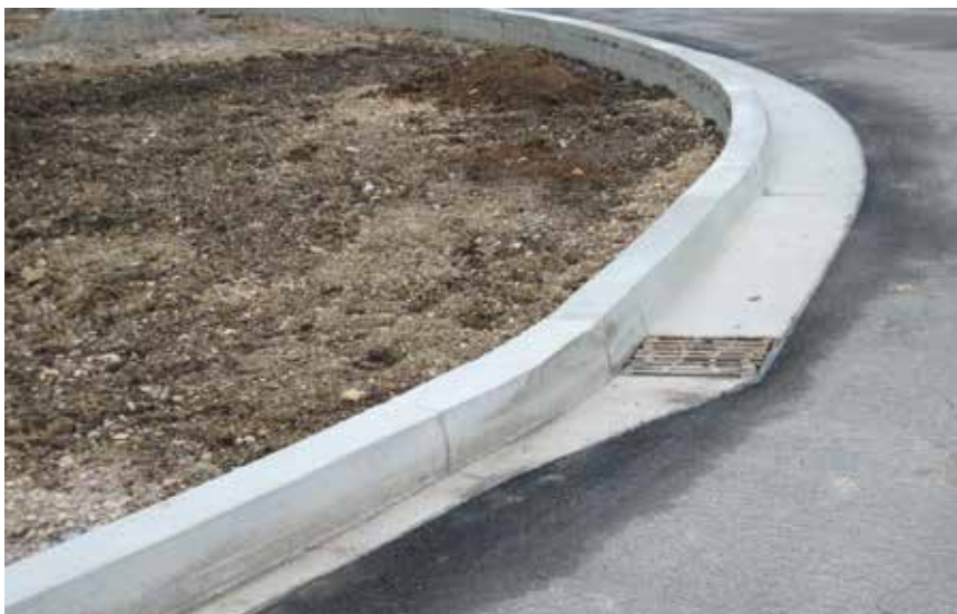
Bild 8: Fahrgasse mit Übergang von Bord zu Bordrinne (Ortbeton)
