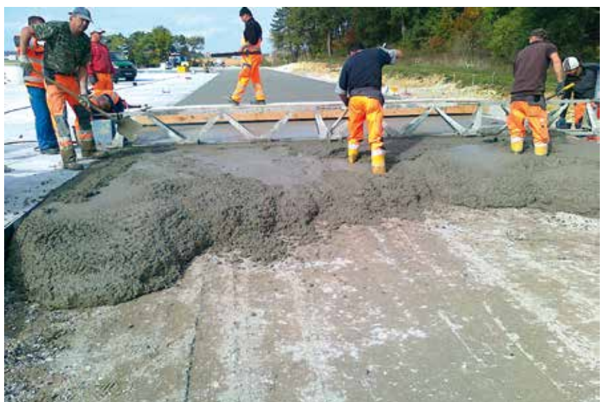
Bild 11: Einbau der Fahrgasse aus Beton auf modifizierter Kiestragschicht
