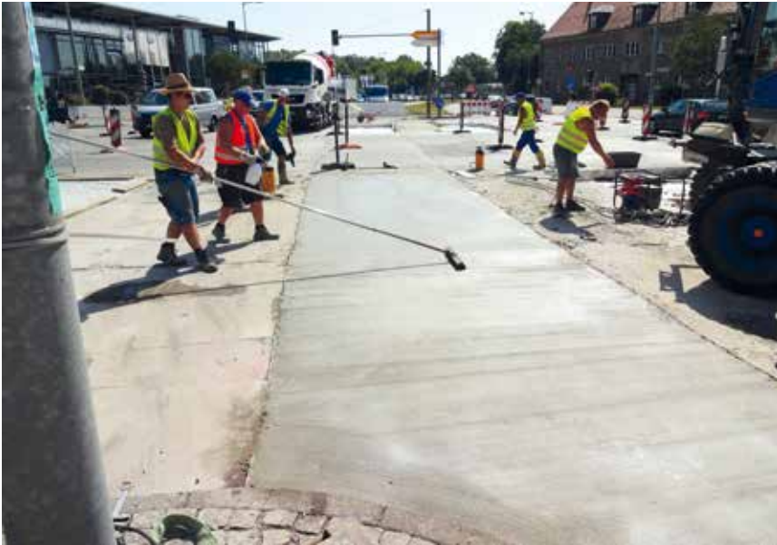
Bild 5: Aufbringen des Besenstrichs
