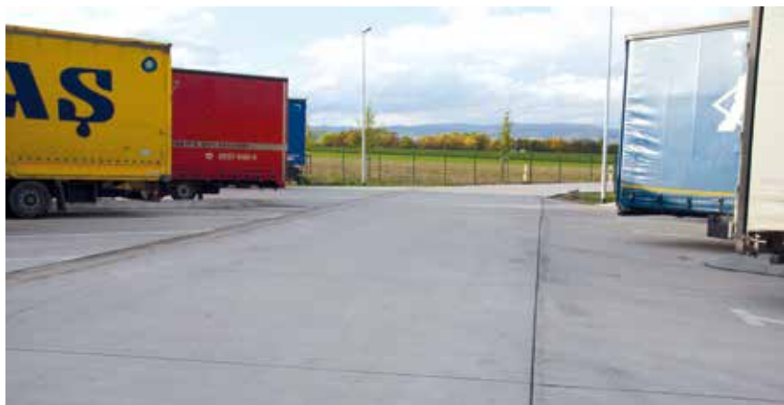
Bild 4: Komplette Rastanlage in Beton (Stellflächen, Fahrgassen sowie Ein- und Ausfahrten)
