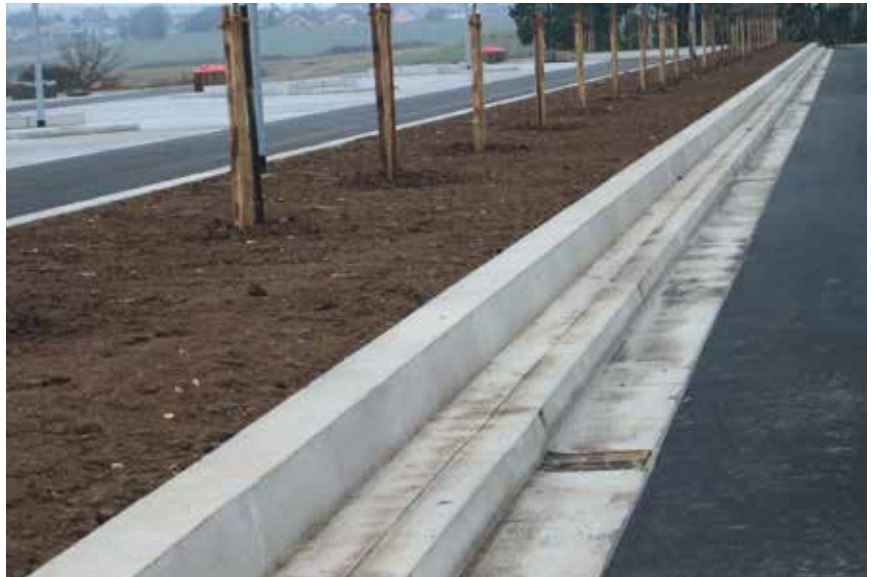
Bild 9: Bordrinne mit angeschlossener Hochbeeteinfassung (beides Ortbeton)
