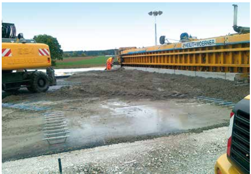
Bild 4: Betoneinbau Lkw-Stellflächen
