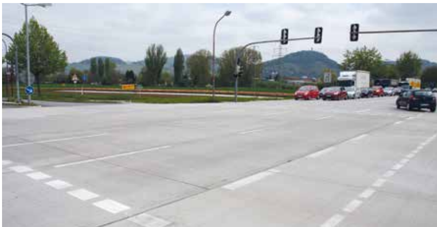
Bild 2: Kreuzungsbereich und angrenzende Bundesfernstraße in Beton
