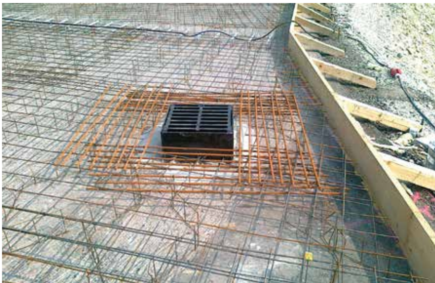
Bild 7: Ablauf verschiebbar mit Eckbewehrung
