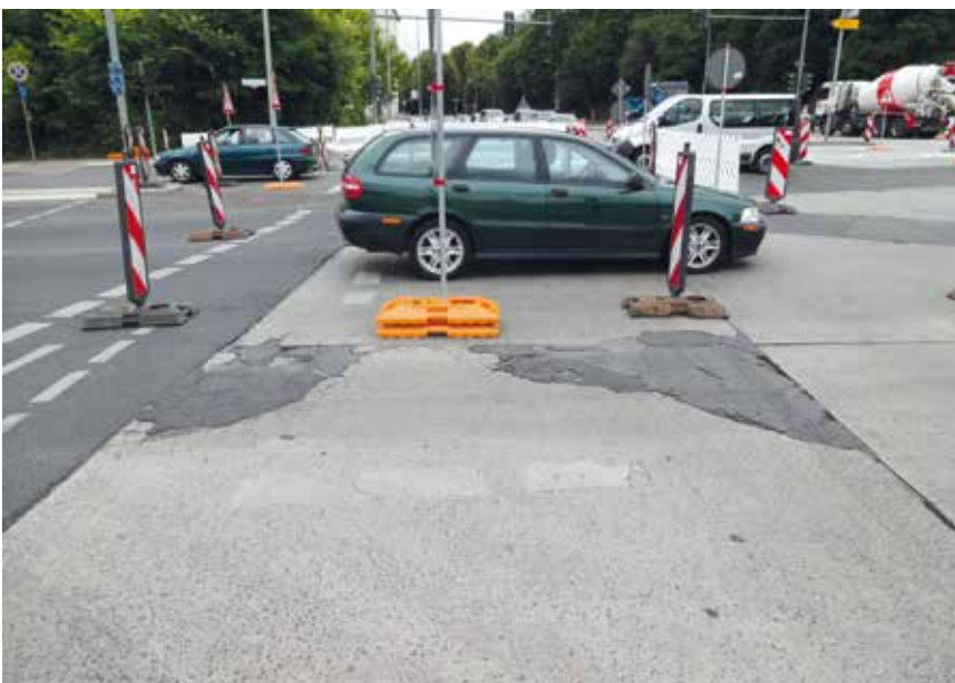
Bild 1: Beseitigung der provisorischen Deckenschlüsse aus Asphalt
