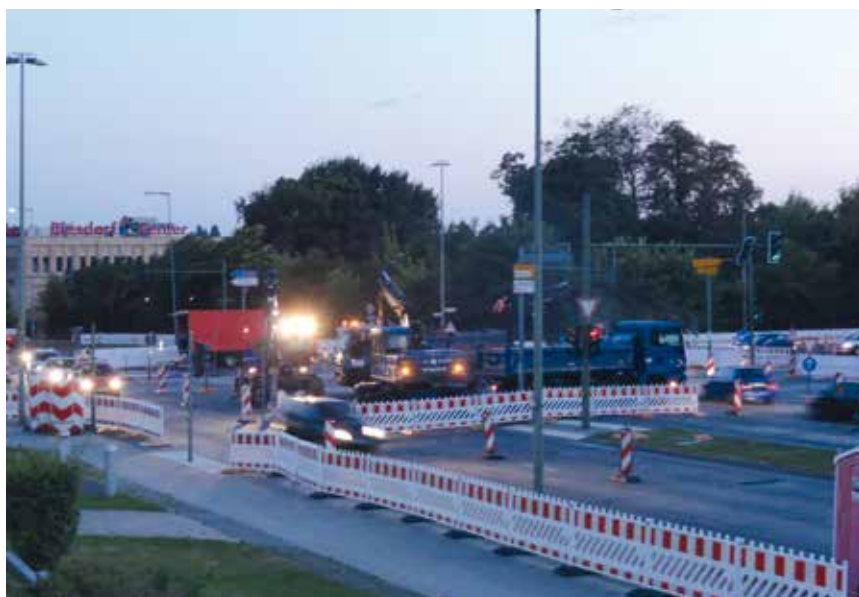
Bild 2: Aufbrucharbeiten mit Mobilbagger und Kipper
