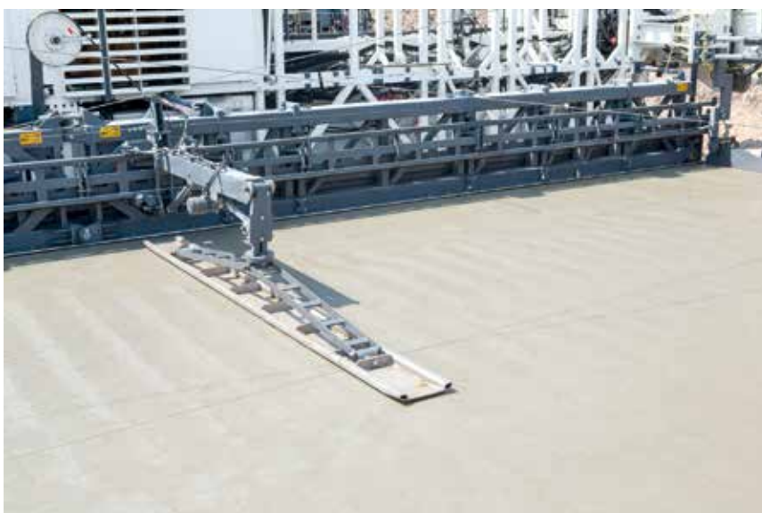
Bild 2: Wirtgen Gleitschalungsfertiger – Multitalente für den Betoneinbau
