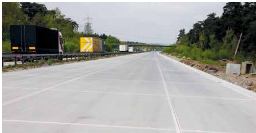
Bild 3: Erneuerung einer Bundesautobahn mit Waschbeton
