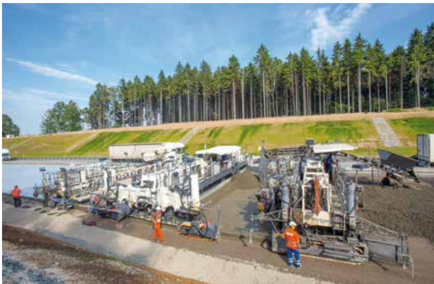
Bild 1: Auf der A9 in Thüringen verbauen Wirtgen Gleitschalungsfertiger 165.000 m 3 Straßenbeton.
