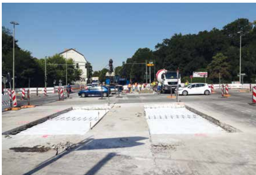
Bild 3: Verdübelte und verankerte Einzelfelder
