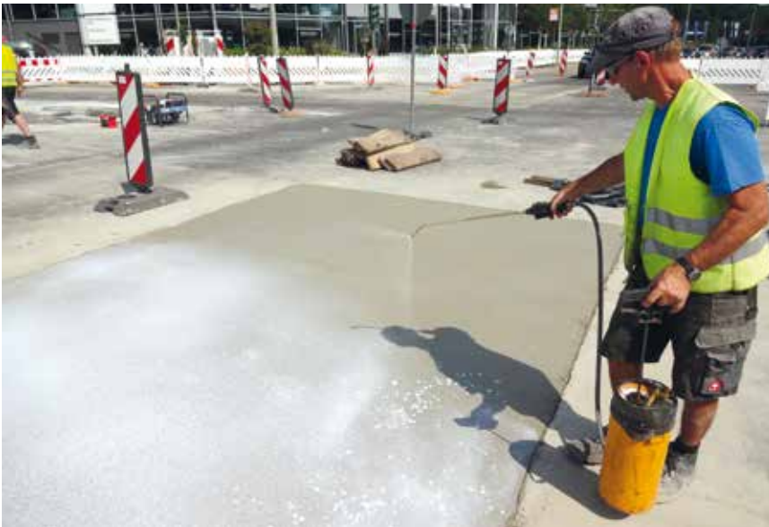
Bild 6: Aufbringen des Nachbehandlungsmittels
