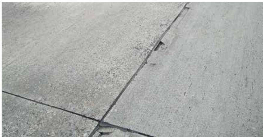
Bild 2: Kantenschäden Betondecke
