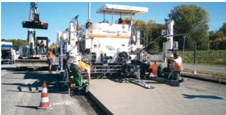
**Bild 9: Gleitschalungsfertiger**
