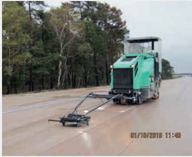
Bild 2: Maschineneinsatz Ebenheits-/Texturgrinding mit Abstavvorrichtung
