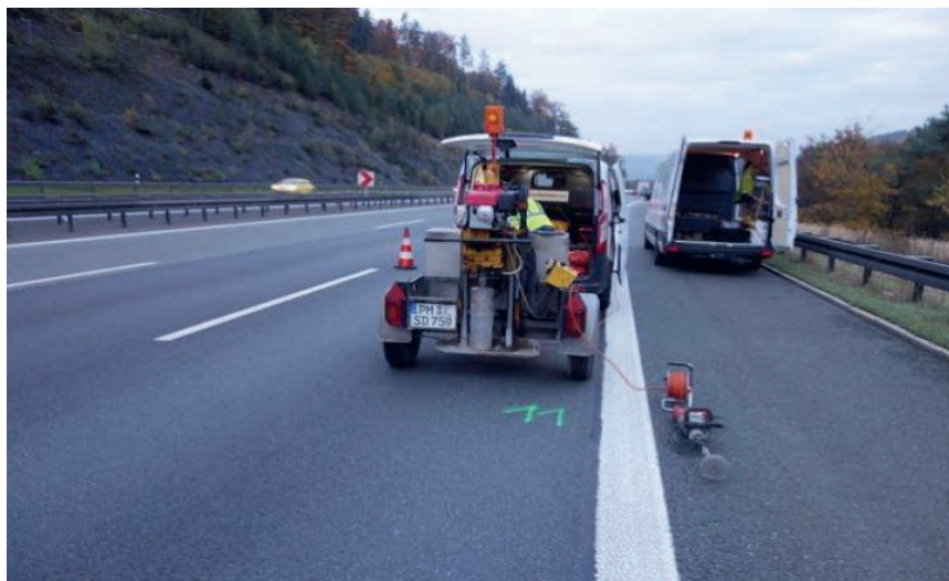
Bild 3: Bohrkernentnahme
