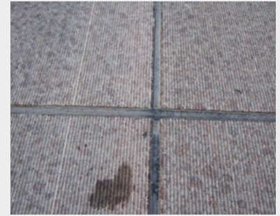
Bild 4: Grindingtextur (2,4/2,2) mit kaltverarbeitbarem 2-Komponenten-Polysulfidverguß (1. BA) für die Fugen
