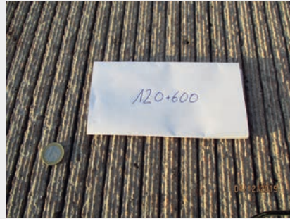
Bild 3: Kombinierte Grinding- (2,4/2,2) und Groovingtextur (2,4/16), Herstellung im kombinierten Verfahren (2. BA, Los 2)
