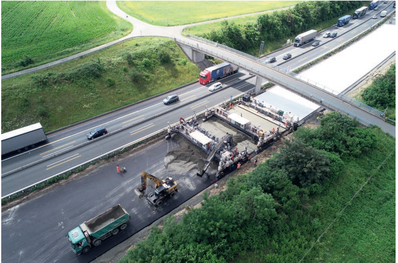
Bild 4: Betoneinbau Richtungsfahrbahn Nürnberg
