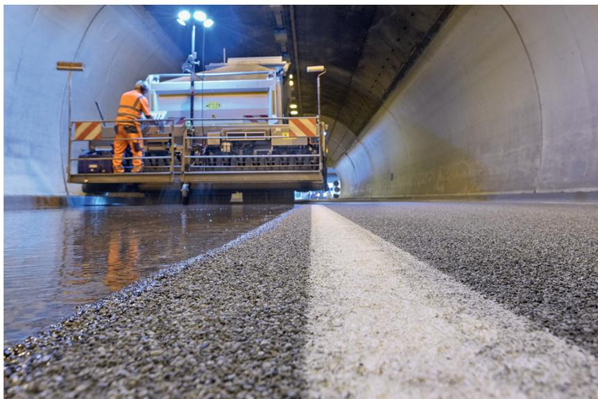
Bild 1: Auftrag des Reaktionsharzes
