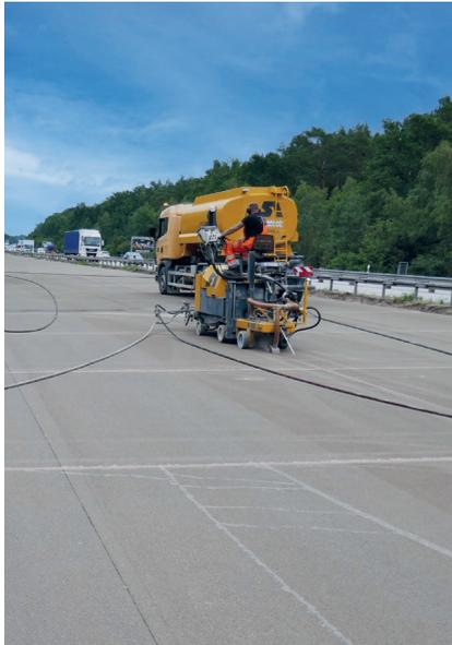
**Bild 10: Fugenschneidarbeiten der Scheinfugen in Quer- und Längsrichtung**
