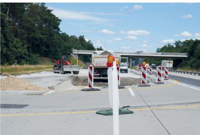
Bild 2: Vorbereitung für die Asphalttragschicht
