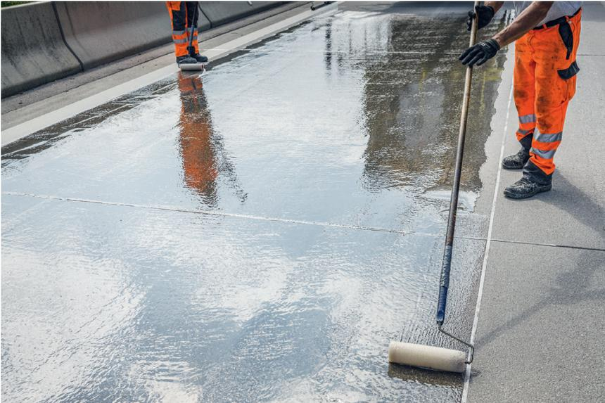
**Bild 3: Herstellen eines definierten Randabschlusses der Beschichtungsfläche**
