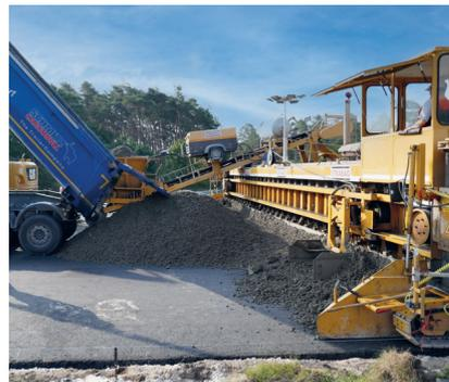
**Bild 5: Anlieferung Unterbeton und Gleitschalungsfertiger beim Betoneinbau**
