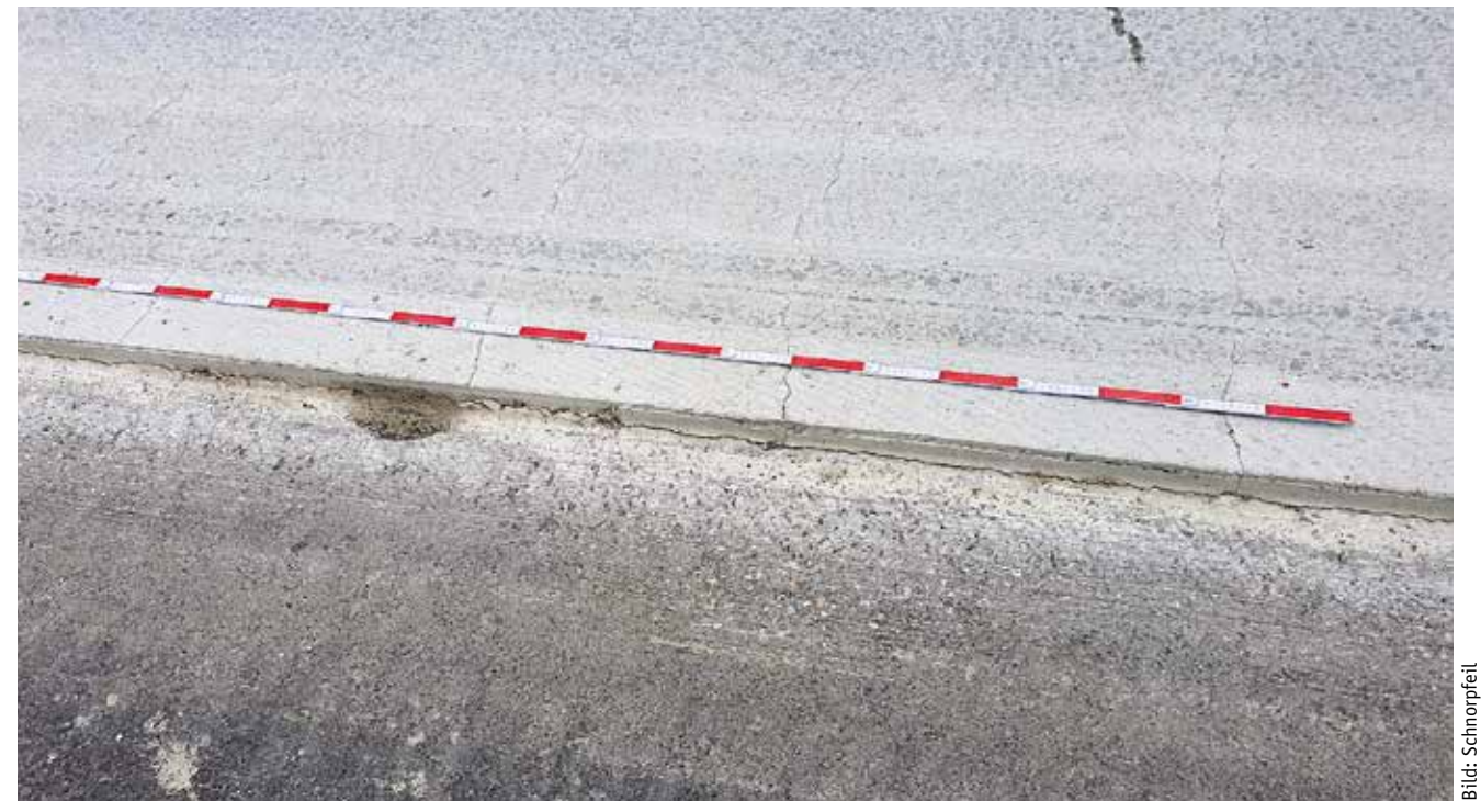
Bild 5: Regelmäßige Rissbildung in der DBB
