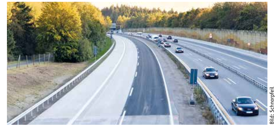
Bild 1: A61 – Fahrbahnabschnitt in horizontal-hybrider Bauweise bedeckt, eingepackt und gewässert.
