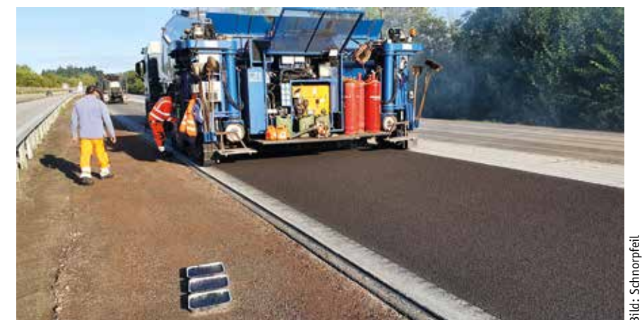
Bild 2: Einbau der Gussasphaltdeckschicht
