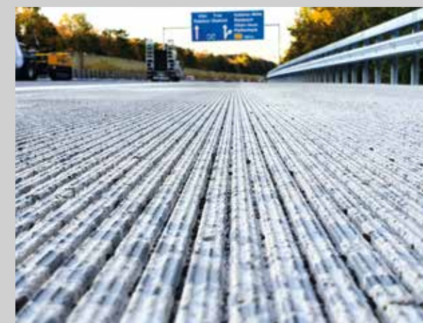
Bild 6: Grindingtextur auf der DBB
