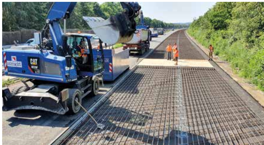
Bild 3: Bewehrung der DBB
