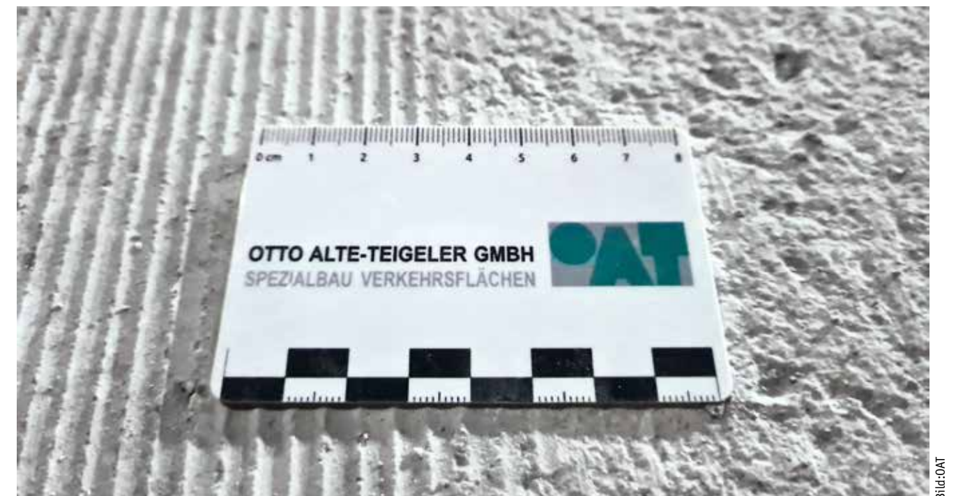
Bild 3: Grinding (links), Übergang zu horizontal geschliffener Oberfläche
