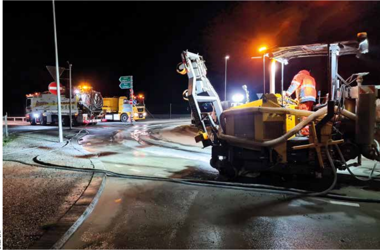
Bild 4: Grindingarbeiten bei Nachtsperung
