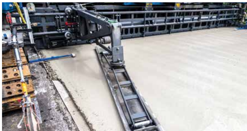
Bild 4: Einbau der Betondeckschicht der DBB
