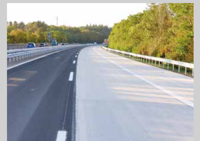
Bild 7: Horizontal-hybride Bauweise – DBB mit Grindingoberfläche
